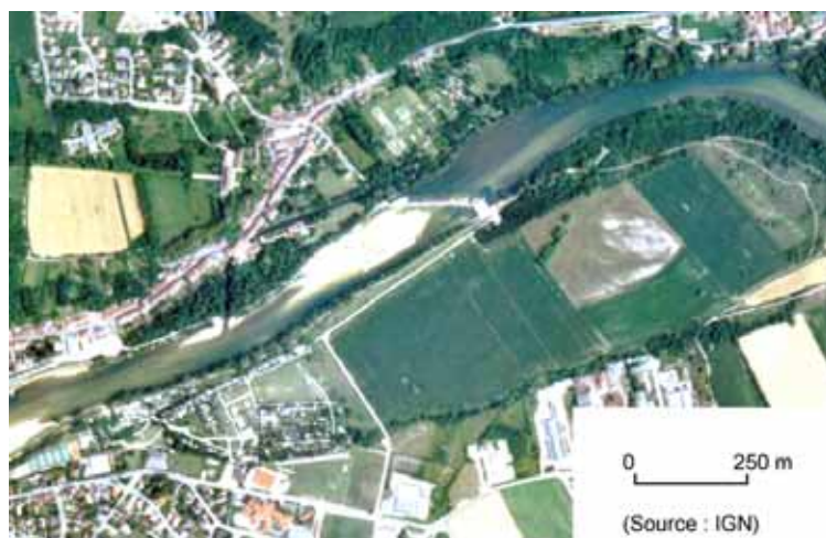
Photographie 2.5 – Vue aérienne du seuil de Pont d'Ain en 2000. Nous pouvons observer que le banc en aval du seuil est artificiellement exondé
