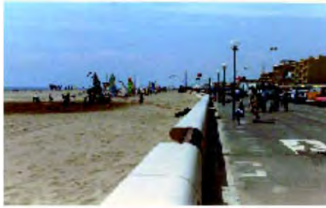
Une nouvelle digue protège la promenade et la première ligne de maisons à Narbonne-Plage - juin 2002.
