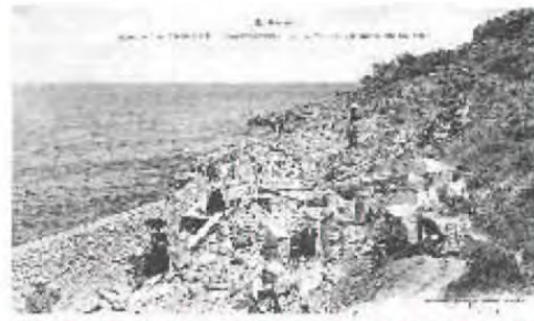
Construction de la route de front de mer dans les années 1910 - Détail d'une carte postale de La Franqui
