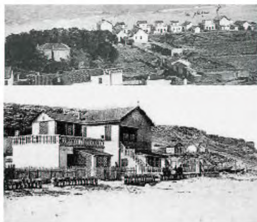
La première ligne de villas édifiées sur le front de mer du Barcarès de Leucate est formée d'habitations standard. Ce modèle unique de villa, reproduit en sept exemplaires, est composé d'un rez-de-chaussée bâti sur une citerne et □ recouvert d'une terrasse et d'un abri. Détails de deux cartes postales du Barcarès de Leucate.
