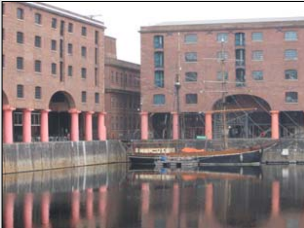
Image 7. Un ancien dock reconverti en logements et galerie commerçante à Liverpool – sur le modèle des docks de Sainte-Catherine à Londres (mars 2005)
