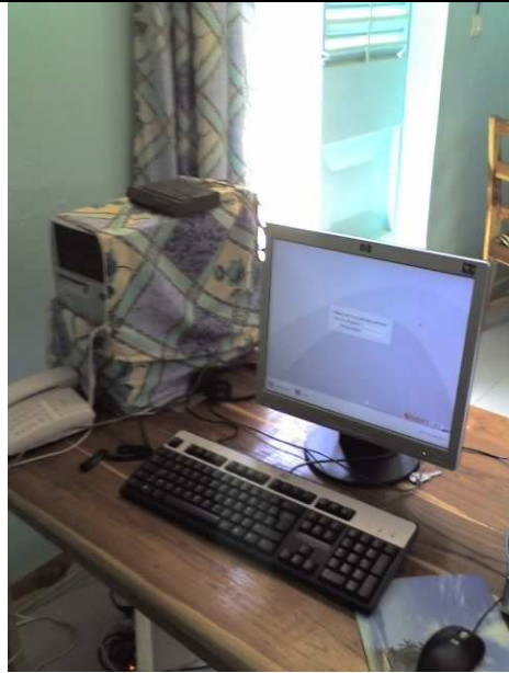
Figure 27: Vue d'ensemble du matériel informatique Pack Aden
