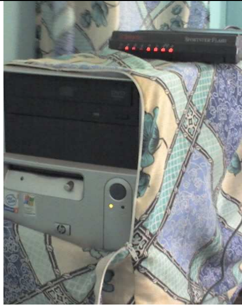
Figure 26: Serveur du centre
