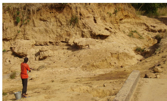
Photo 5.1 : Erosion au pont de la Mékrou
