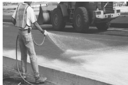
Figure I-43: Pulvérisation du produit de cure à la surface du béton.
