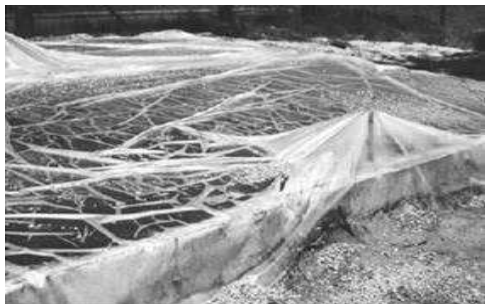
Figure I-44: Usage d'un polyane recouvrant la surface du béton.
