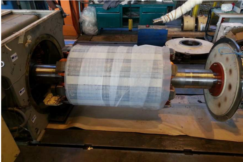
Figure 4-24 : Rotor après l'installation de la frette
