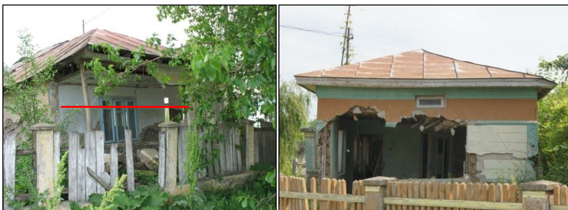
Figure 1- 29: Exemple de maisons considérées comme abandonnées-détruites ; le trait rouge marque la hauteur d'eau atteinte en juillet 2005 (Photographies : F. Salit, juin 2012)
