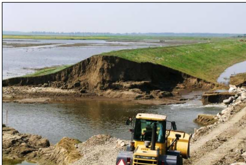
Figure 2- 16: Réparation provisoire d'une digue sur la rivière Geru dans la zone de Lungoci, travaux exécutés par ANAR en 2010 (Photographie : ANAR)
