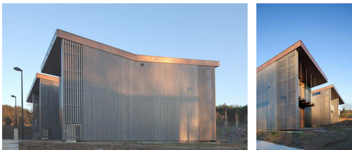
Figure 1.5 : Exemple des maisons du quartier Arrousets à Bayonne qui intègrent un bardage pin maritime ventilé devant une isolation par l'extérieur
