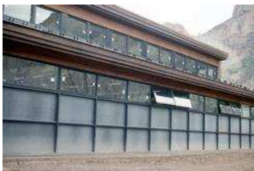
Figure 1.2 : Mur Trombe du parc national Zion, Utah Etats Unis, étudié par Torcellini et Pless (2004)
