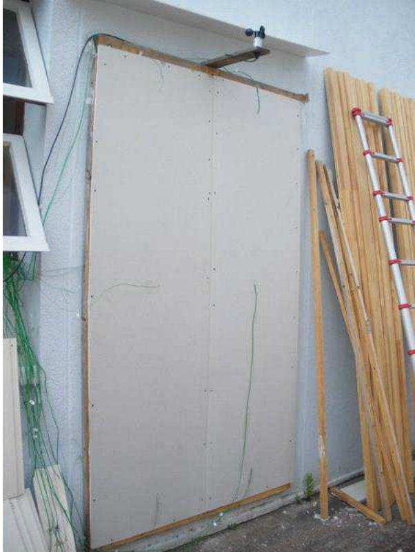
Figure 2.3 : Premier panneau de BA13 posé, thermocouples placés.
