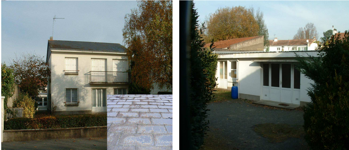
(a) Toit en ardoise
