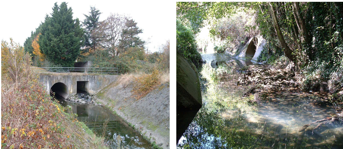
FIGURE 2.5 – Photographies du ruisseau des Gohards. Amont du ruisseau : partie à ciel ouvert (à gauche). Exutoire des eaux de ruissellement B.V des Gohards (à droite)
