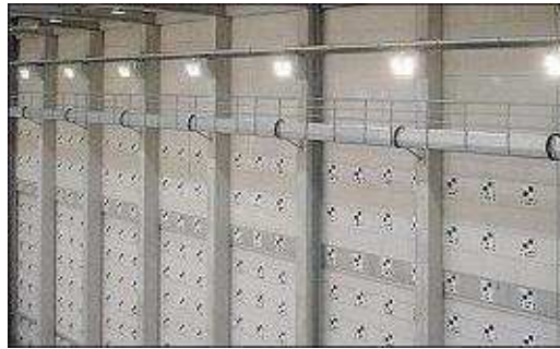
FIG. B.2: Vue des mires réparties sur le mur droit de l'installation.
