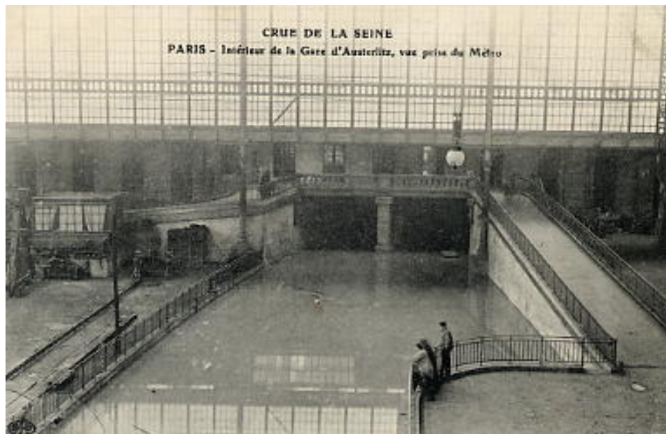
FIG. 13 : Intérieur de la gare d'Austerlitz
