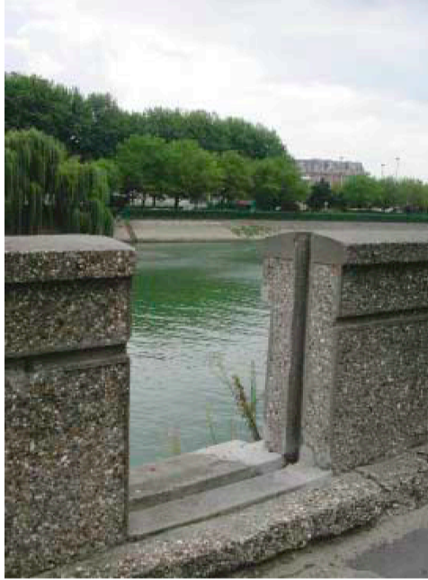
FIG. 1.1 : Murette anti-crue et emplacement du batardeau (Courbevoie)
