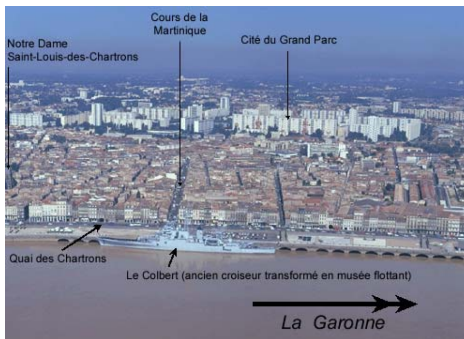
Photographie 20 – Cliché A. Dalbavie. Vue aérienne du quartier des Chartrons avec en arrière plan la cité du Grand Parc.
