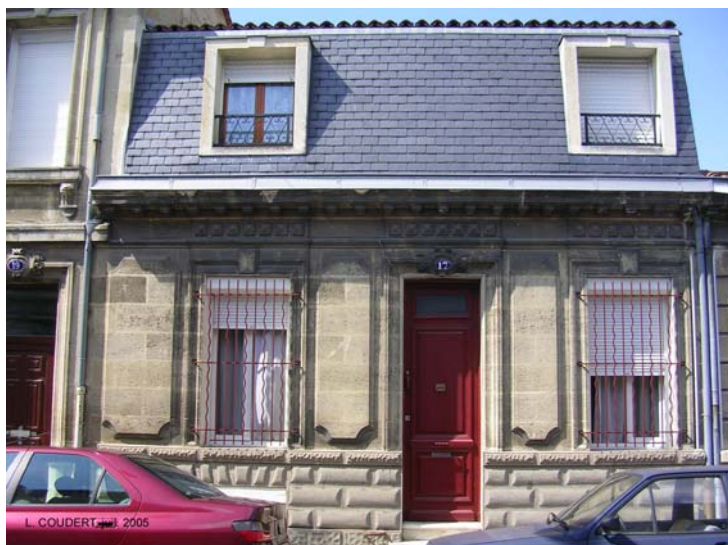
Photographie 21 – Échoppe bordelaise surélevée d'un niveau.
