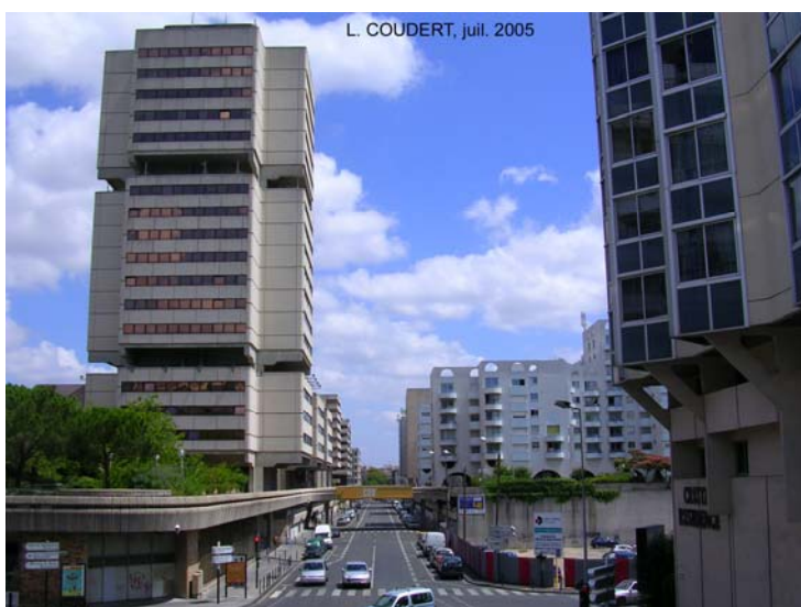
Photographie 39 – La tour de la Communauté Urbaine de Bordeaux (CUB) et la rue Jean Fleuret, au sud de la dalle centrale de Mériadeck.
