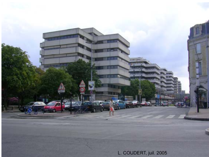
Photographie 37 – Les tours des AGF, vues depuis la place du Colonel Raynal.
