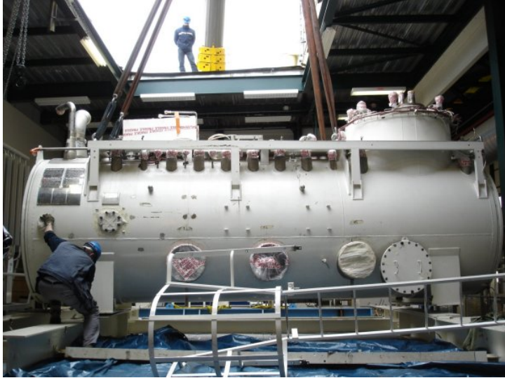
FIGURE 4.1 – La boîte froide pendant son installation
