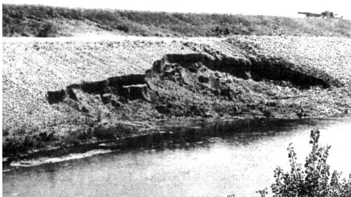
figure 2-18, Exemple de rupture de talus aval (Brun, 1993)
