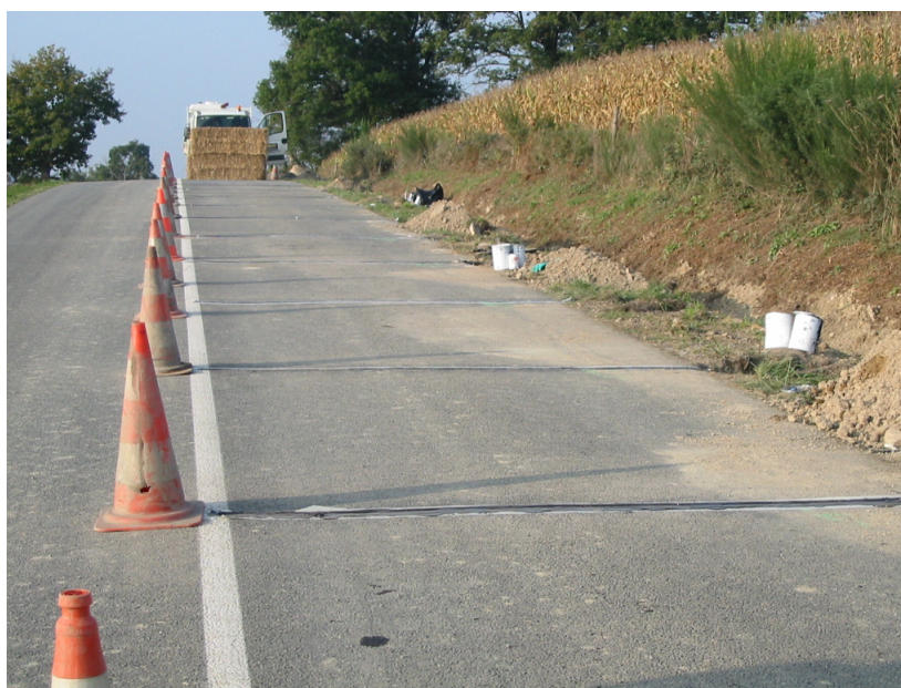
FIGURE E.5 – Visualisation de la position des capteurs dans la chaussée dans le sens Marans vers Segré avant le sommet de côte. La résine a été coulée.
