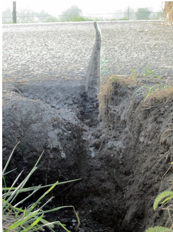
FIGURE E.3 – Une saignée dans la chaussée de la route.
