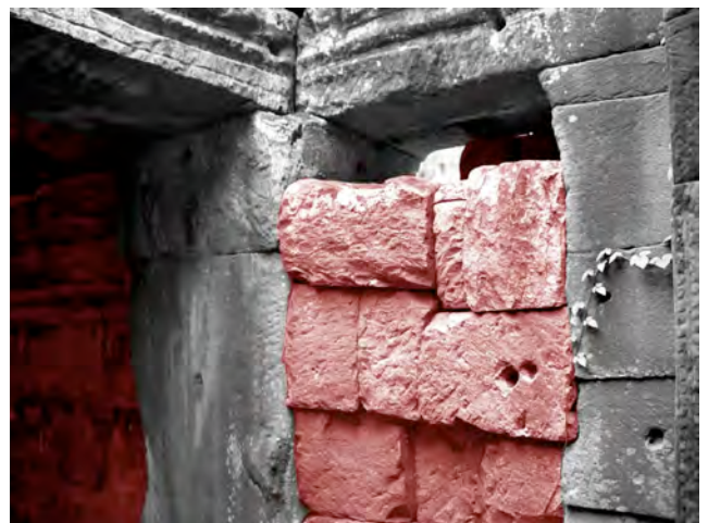
Ph. 176 : Bouchage occidental du porche Sud de BY.23
