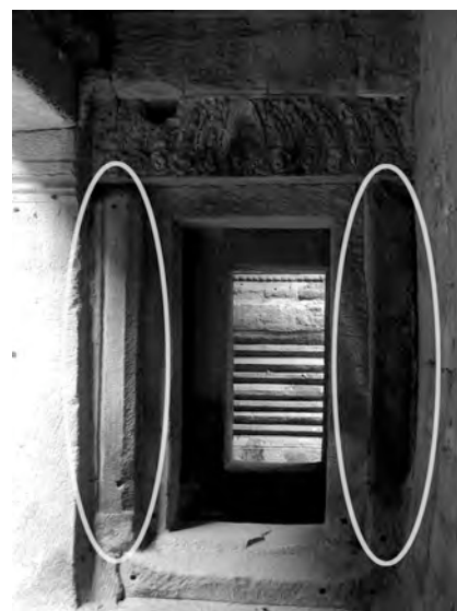
Ph. 137 : Exemple de colonnettes en attente de décor à l'entrée Sud de la tour BY.40
