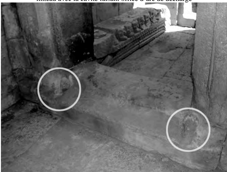
Ph. 18 : Seuil présentant des crapaudines pour le tourillon inférieur des deux vantaux en bois
