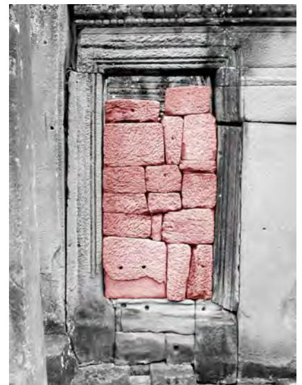
Ph. 241 : Bouchage d’une fenêtre de BY.67 côté cour du premier étage
