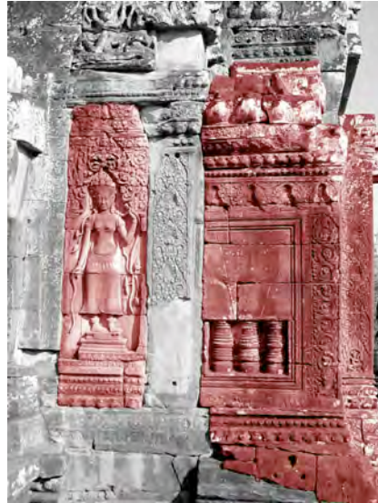
Ph. 197 : Blocage (en rouge) de la loggia Sud-Est de la tour BY.15
