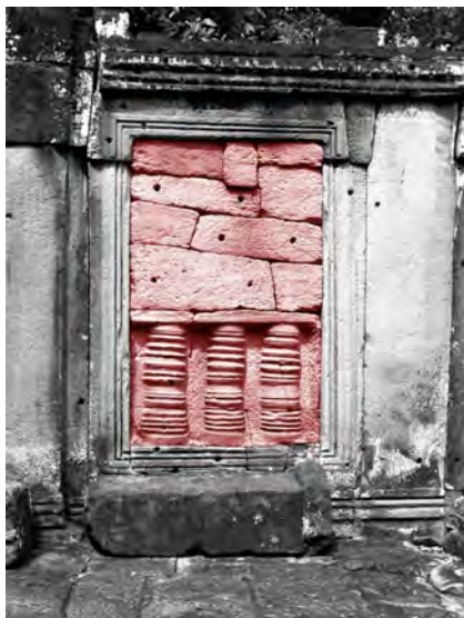
Ph. 239 : Bouchage d’une fenêtre de BY.55 côté cour du premier étage
