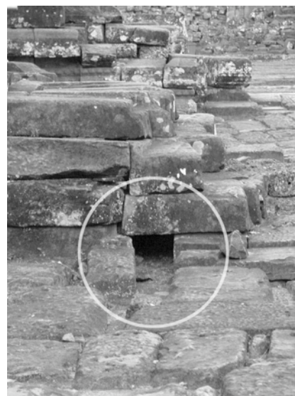
Ph. 114 : Conduit de drainage dans le soubassement de la salle-passage BY(I)
