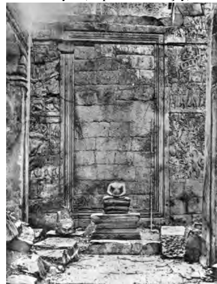
Ph. 250 : Exemple de porte bouchée de la galerie extérieure du Bayon (H. Dufour)
