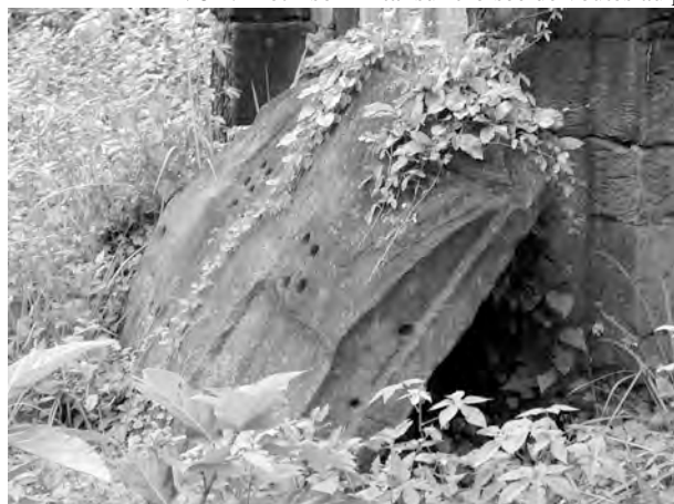
Ph. 85 : Pierre constituant originellement l'extrados de la croisée de voûte du pavillon d'angle Sud-Est PK.101 de l'enceinte du complexe occidental du Preah Khan d'Angkor
