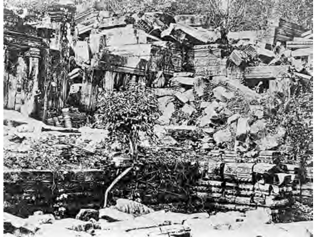
Ph. 36 : Pavillon du premier étage avant les travaux de dégagement (CA)
