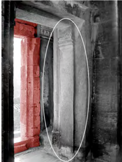
Ph. 196 : Porte orientale intérieure de la tour BY.15
