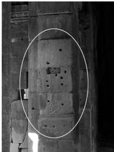
Ph. 191 : Face Est du pilier Sud-Ouest intérieur de l'édifice BY.14
