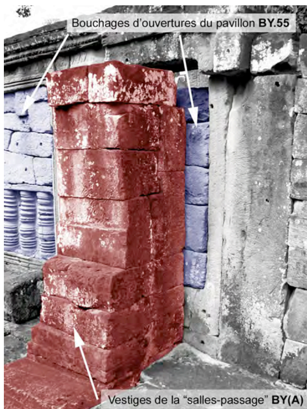
Ph. 109 : Vestige du mur Nord de la chambre principale de BY(A) s'appuyant sur l'embrasure obturée de l'avant-corps Sud de BY.55
