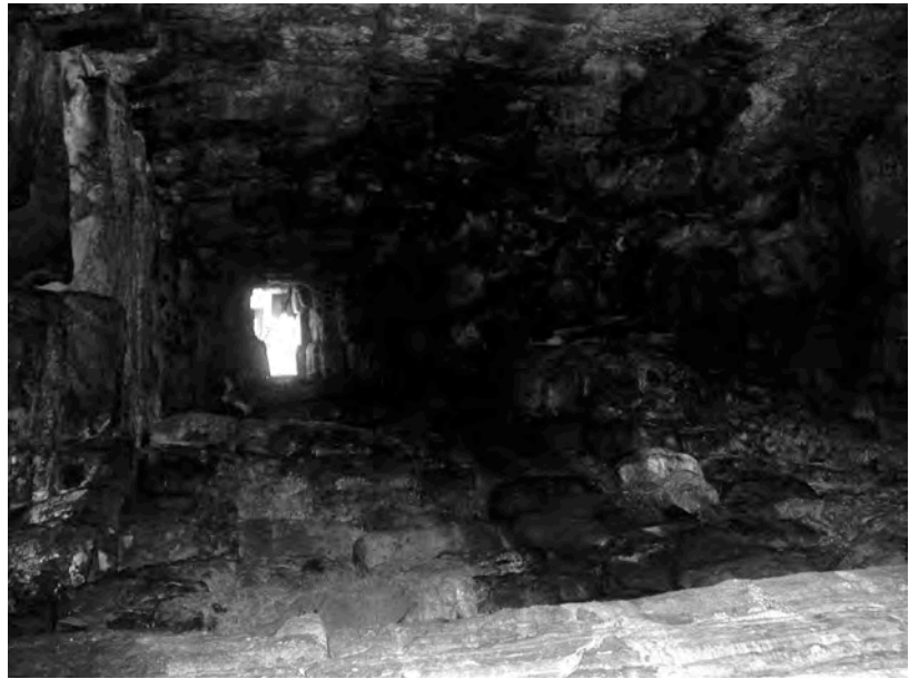
Ph. 174 : Intrados de la cheminée de la tour BY.2
