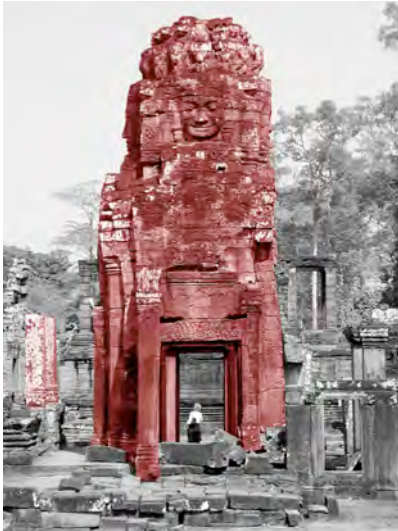
Ph. 232 : Face Sud de la tour BY.52
