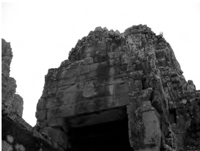
Ph. 175 : Fronton du porche Nord de la tour BY.31 du Bayon
