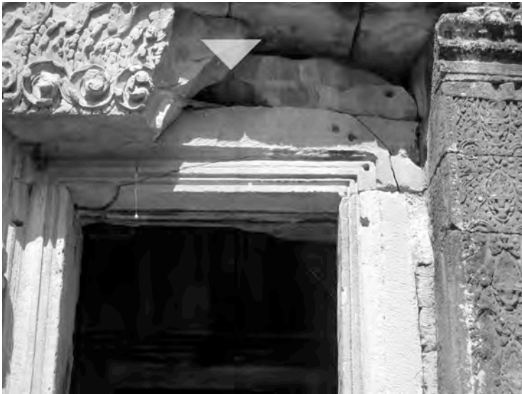
Ph. 16 : Linteau décoratif ruiné montant l'assise reposant sur le vrai linteau avec la cavité faisant office d'arc de décharge
