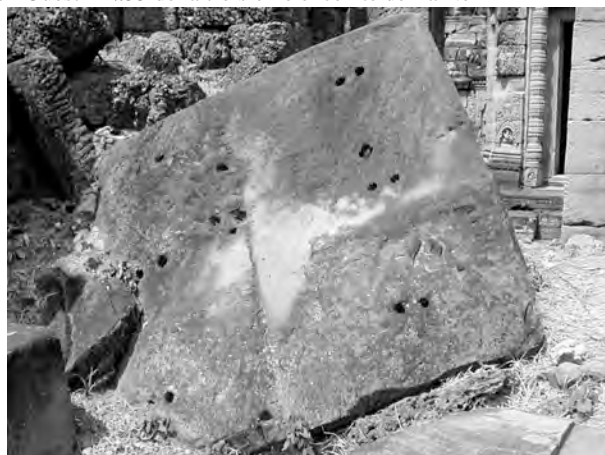
Ph. 86 : Pierre formant originellement l'extrados de la croisée de voûte du pavillon Est PP.4 de la première enceinte de Prasat Prei
