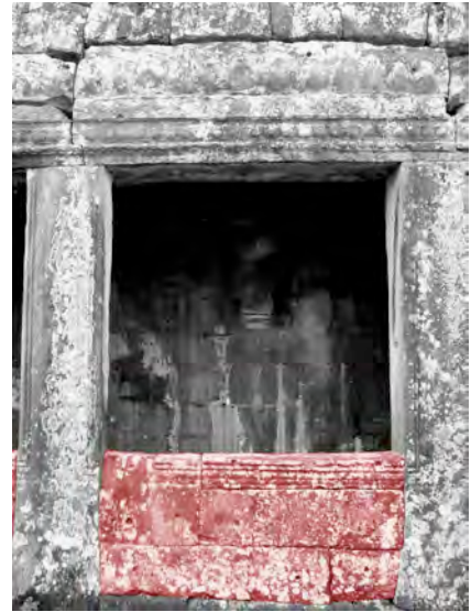
Ph. 215 : Adjonction d'allège à la galerie inférieure BY.47-37
