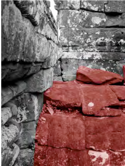
Ph. 184 : Extrados du bas-côté Sud de l'avant-corps occidental de la tour BY.22
