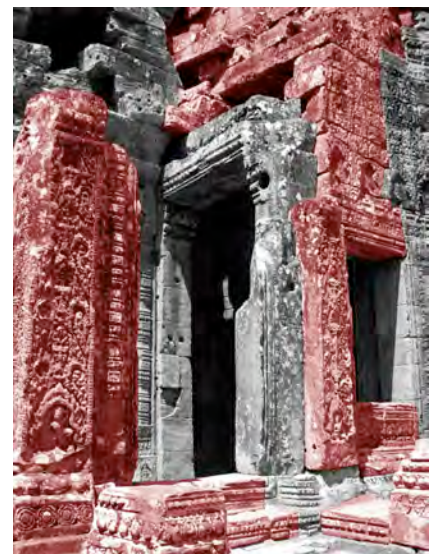
Ph. 201 : Avant-corps Nord (en rouge) de la tour BY.12
