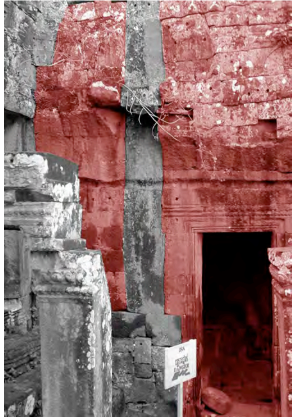
Ph. 178 : Connexion entre la galerie BY.27-28 (en rouge) et l'avant-corps Sud de la tour BY.27 (vue de la courette de l'angle Sud-Ouest du 2 ème étage)
