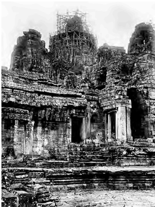
Ph. 38 : Échafaudage de la tour centrale durant sa restauration par G. Trouvé (CA)
