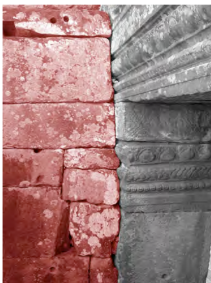
Ph. 162 : Connexion entre le mur d'échiffre de l'escalier Sud du soubassement du troisième étage et le porche Nord de la tour BY.26
