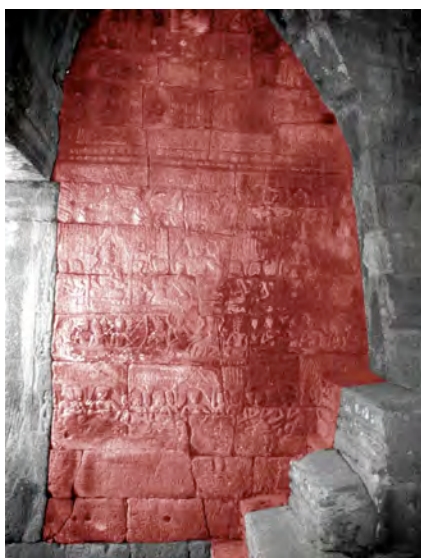
Ph. 209 : Bouchage (en rouge) de la face Nord de la loggia Nord-Est de la tour BY.22
