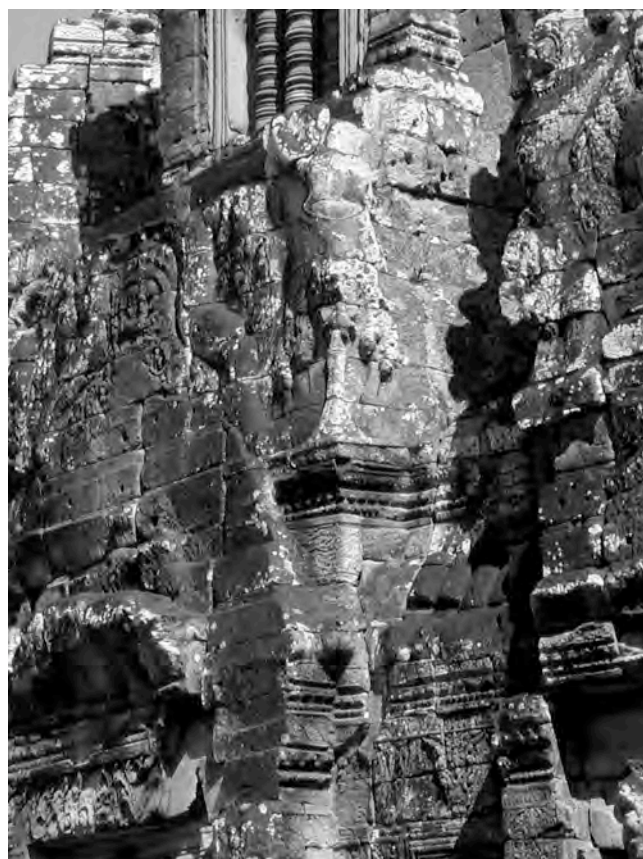
Ph. 83 : Exemple de tour à visages du massif central avec garuda d'angle (Tour BY.4 )
