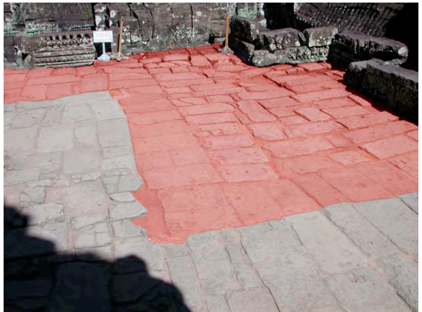
Ph. 206 : Extension de la terrasse du troisième étage (en rouge) englobant la face Sud de la tour BY.51 et la face Ouest de la tour BY.47
