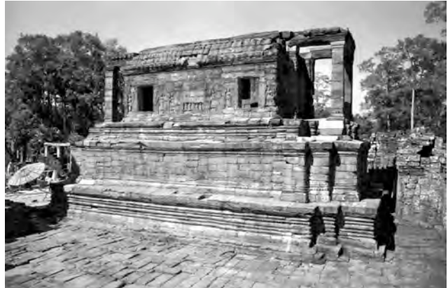
Ph. 41 : "Bibliothèque" Nord après restauration (JSA)
