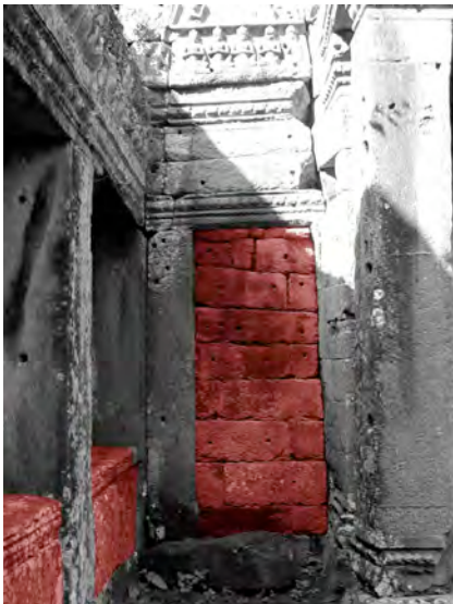
Ph. 216 : Bouchage de la loggia Sud-Est de la tour BY.49
