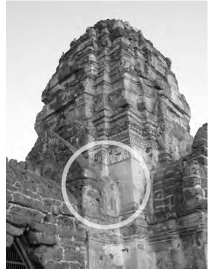
Ph. 32 : Exemple de superstructure présentant des traces d'enduit au Prang Sam Yod (Lopburi, Thaïlande)
