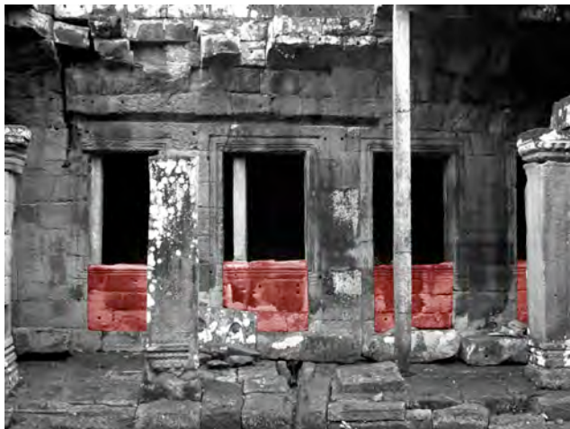
Ph. 221 : Adjonctions d'allèges à la galerie BY.32-33 (vue de la courette de l'angle Nord-Ouest du 2 ème étage)
