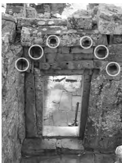
Ph. 125 : Empreintes de la charpente du porche de la porte Nord de BY.70
