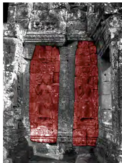
Ph. 229 : Bouchages des accès extérieurs Nord entre BY.14 et BY.15
