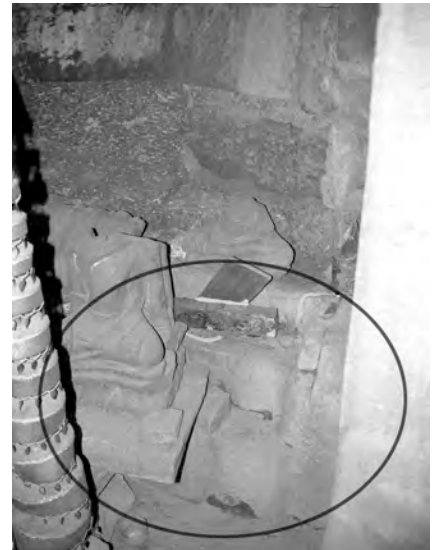
Ph. 143 : Premières marches de l'escalier axial Est du soubassement du troisième étage dans l'avant-corps Ouest de BY.22
