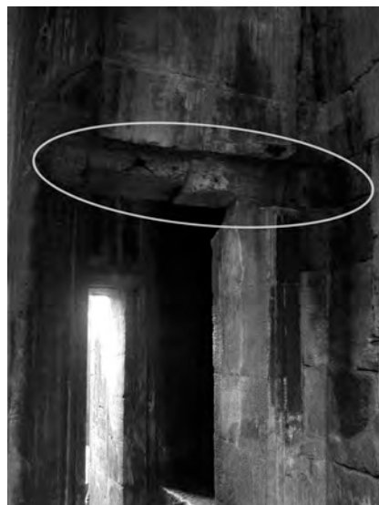
Ph. 200 : Logement de poutre au-dessus de la porte latérale Nord-Ouest de BY.12
