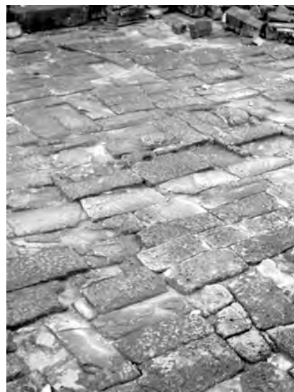
Ph. 117 : Dallage entre la salle-passage BY(G) et BY(H)
