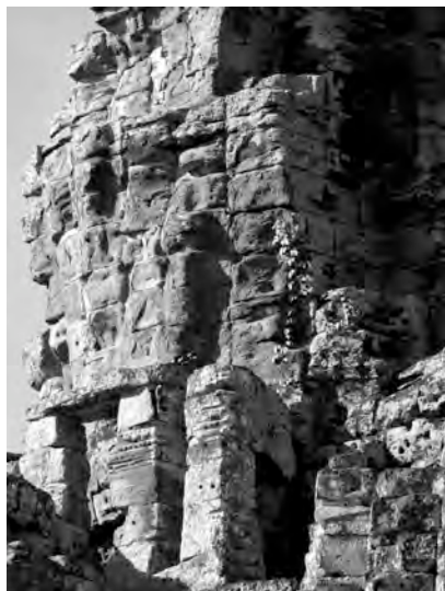
Ph. 71 : Face Nord de la tour BY.1
