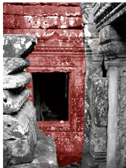
Ph. 183 : Bas-côté Sud de l’avant-corps occidental de la tour BY.22
