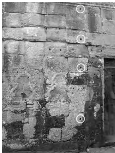
Ph. 131 : Extrémité Ouest de la galerie BY.23-38
