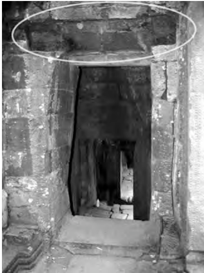
Ph. 213 : Porte ouverte dans la loggia Sud-Ouest de la tour BY.23
