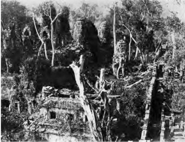
Ph. 35 : État du Bayon avant les travaux de débroussaillage (Melies)
