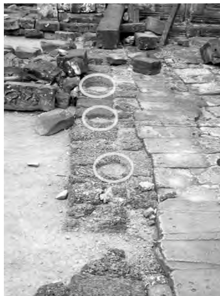
Ph. 128 : Exemple de trous de poteaux dans les fondations de la salle-passage BY(H)
