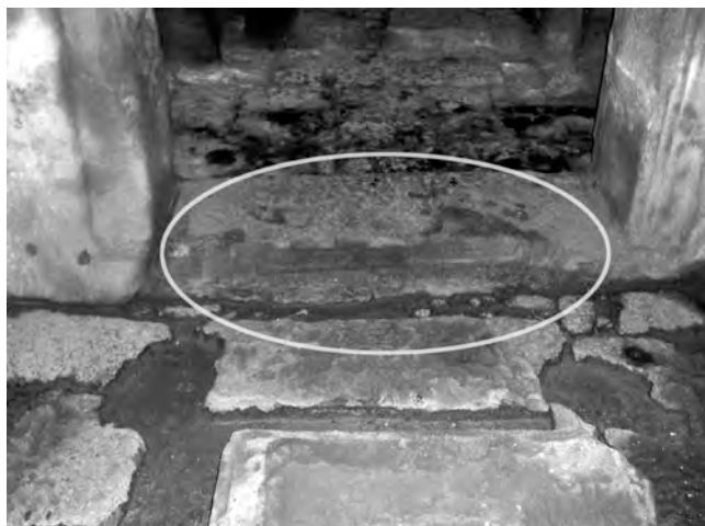
Ph. 147 : Traces du premier encadrement de porte Ouest du mur (face extérieure) du tambour extérieur de la tour BY.1
