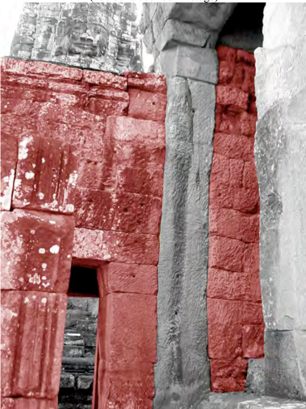
Ph. 179 : Connexion entre la galerie BY.31-32 (en rouge) et l'avant-corps Sud de la tour BY.31 (vue de la cour du 1 er étage)
