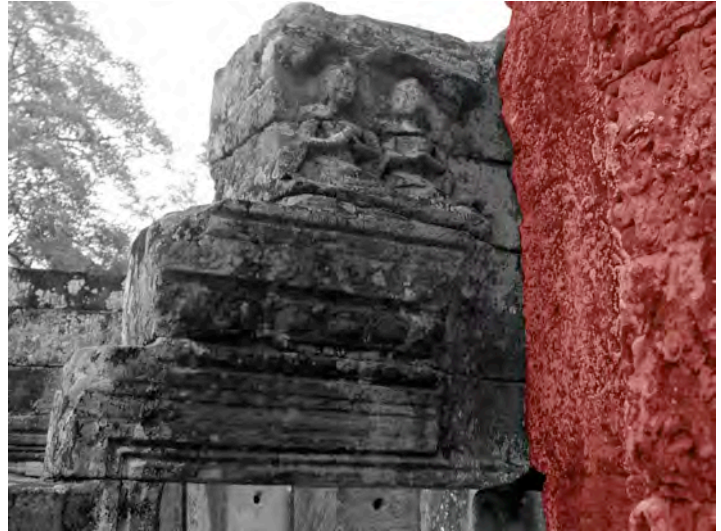
Ph. 233 : Connexion entre le demi-fronton du bas-côté Nord de l'avant-corps Ouest du pavillon d'entrée BY.55 et la tour BY.52
