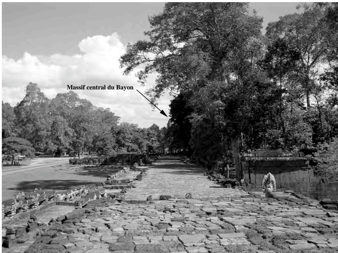
Ph. 7 : Vue vers le Sud du centre de la plateforme supérieure du perron central de la Terrasse des Éléphants
