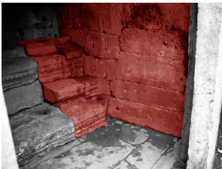
Ph. 210 : Bouchage (en rouge) de la face Sud de la loggia Sud-Est de BY.22 et extension de l'escalier donnant accès à la galerie supérieure de BY.22-23
