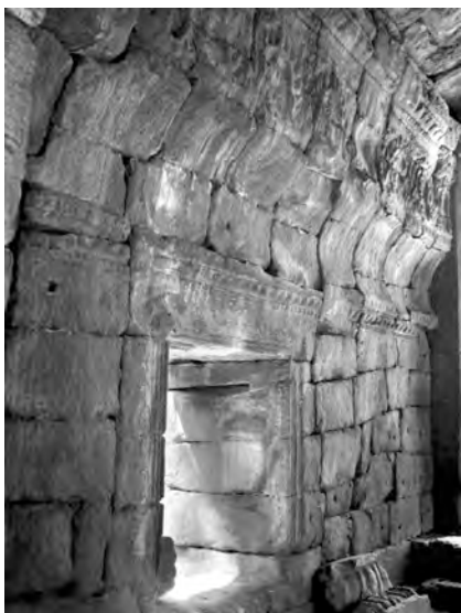
Ph. 115 : Mur sud de la salle-passage BK.31 de Banteay Kdei
