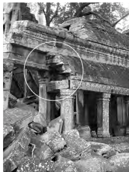
Ph. 160 : Bas-côté extérieur de la galerie de la troisième enceinte de Ta Prohm
