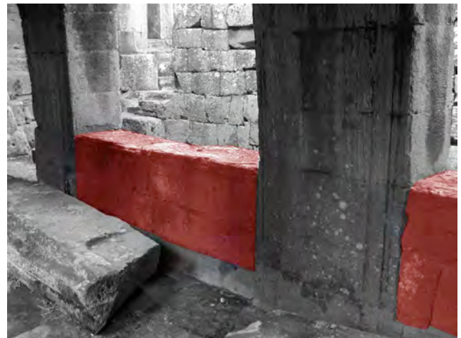
Ph. 222 : Adjonctions d'allèges à la galerie BY.31-32 (vue de son bas-côté intérieur)
