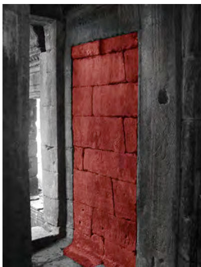
Ph. 227 : Bouchage de la porte latérale Nord entre BY.14 et BY.15
