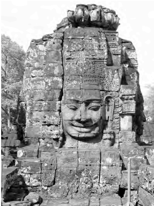
Ph. 77 : Face Sud de la tour BY.51
