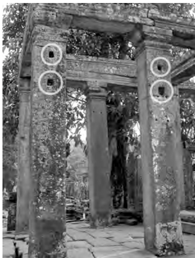
Ph. 123 : Logement d'une ossature en bois dans les piliers du porche Est du pavillon BY.55
