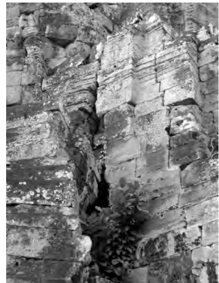
Ph. 172 : À droite, cheminée reposant sur la première voûte de BY.11 et s'appuyant sur BY.3
