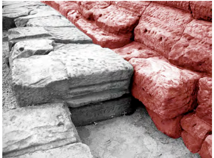
Ph. 245 : Base de la “salle-passage” BY(N) et soubassement de la “bibliothèque” BY.54
