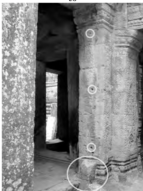
Ph. 133 : Pilastre Nord de l'entrée orientale de la tour BY.40
