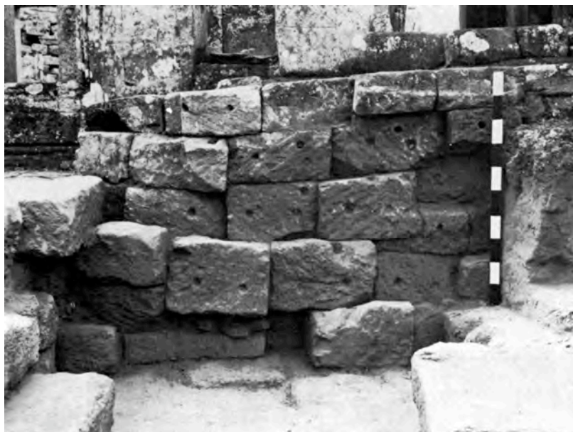
Ph. 238 : Sondage By 1, soubassement de la tour BY.52 (CA)
