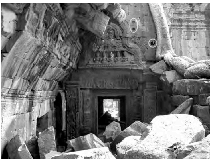
Ph. 122 : Exemple de traces d'appentis prévus originalement et remplacés par la "salle-passage" en grès TP.80 entre l'entrée occidentale de TP.103 et l'avant-corps oriental de TP.57 à Ta Prohm
