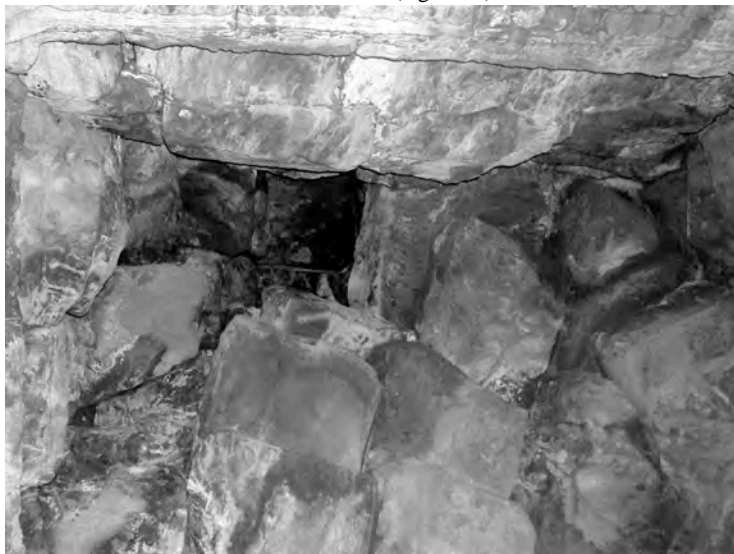
Ph. 171 : Intrados de la première voûte de BY.11
