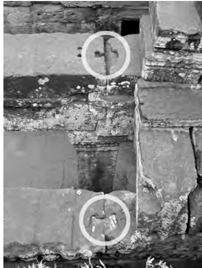
Ph. 26 : Exemple de logement de crampons entre architraves
