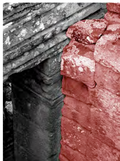
Ph. 163 : Connexion entre le mur d'échiffre de l'escalier Nord du soubassement du troisième étage et le porche Sud de la tour BY.34
