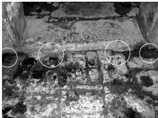
Ph. 148 : Première et seconde série de crapaudines de porte Ouest (face intérieure) du mur du tambour extérieur de la tour BY.1
