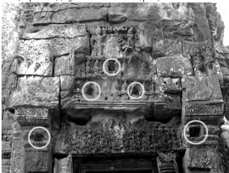
Ph. 120 : Exemple de traces d'appentis rajoutés après le programme décoratif de l'entrée Sud de la tour TP.60 à Ta Prohm
