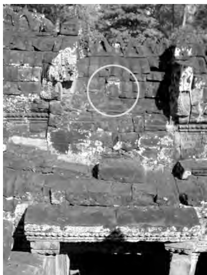
Ph. 164 : Porche intérieur de la galerie BY.22-23
