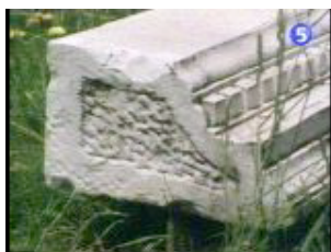
6:04:48:19 / la vo : continue de décrire la maçonnerie diversité maçonneries
