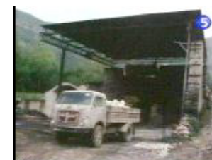
6:11:40:24 diversité matériaux 6:11:44:00 diversité matériaux
