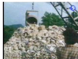
6:10:34:12 diversité matériaux 6:10:46:00 diversité matériaux
