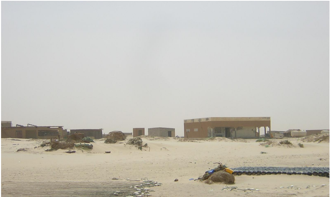
Photo 14 : Des habitations en dure à M'maghar
