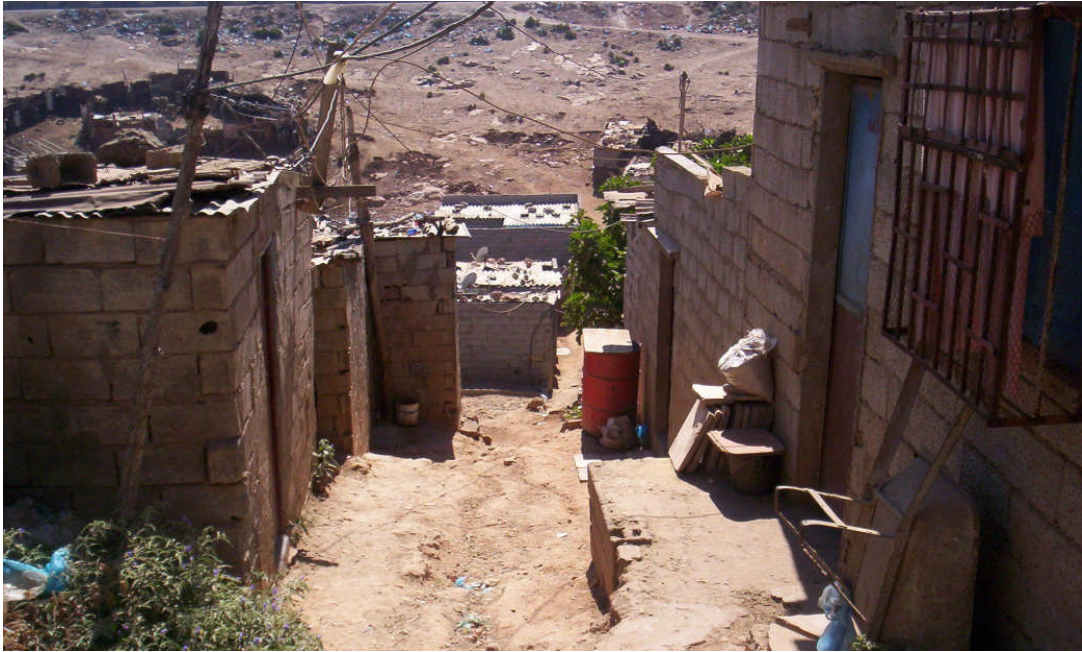
Figure 2-4 : Construction de bidonville sur l'Oued à Ain EL Beida (septembre 2008).
