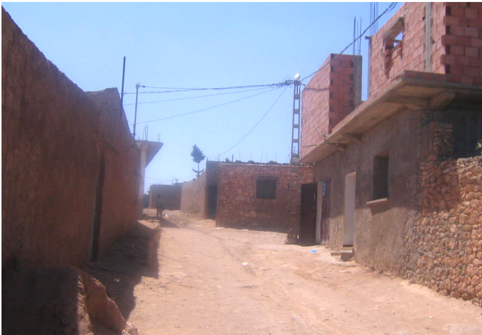
Figure 2-3 : une maison à deux niveaux avec des poteaux poutres, rendant possible une plus longue durée pour la construction, (septembre, 2008).
