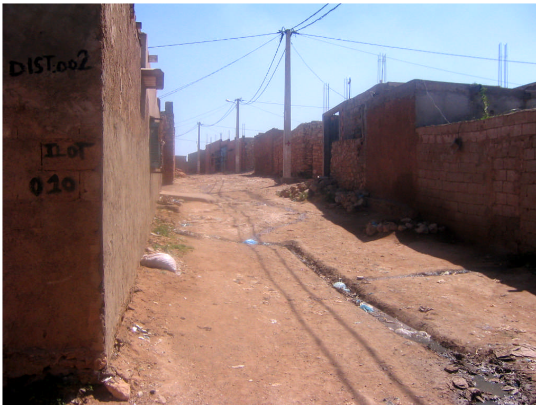
Figure 6-1 : Des canalisations à ciel ouvert au Douar de Med Boudiaf (août, 2008)
