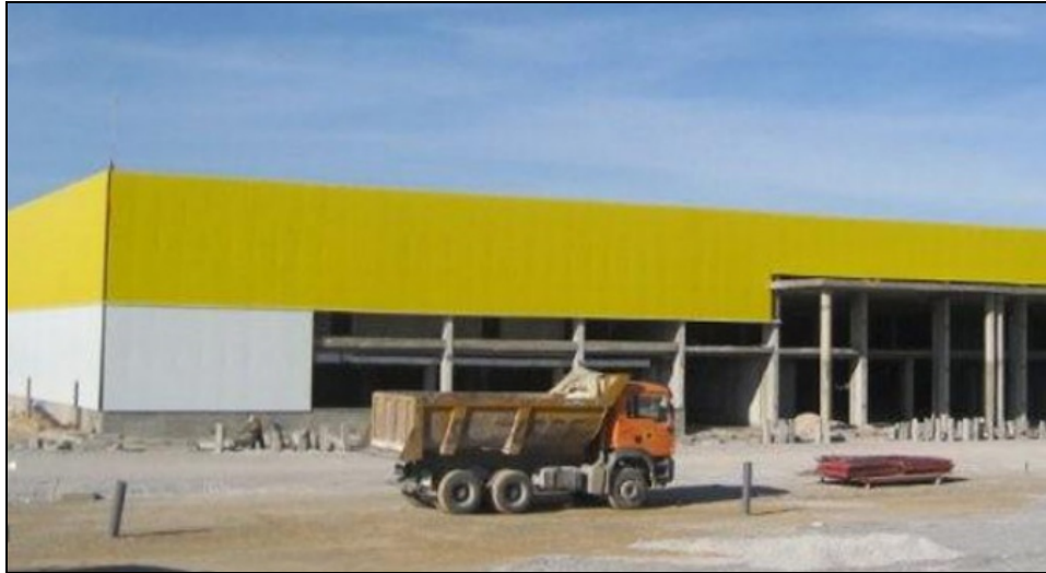
Photo n°36 : Bricorama-Tunisie : Chantier de finalisation.
