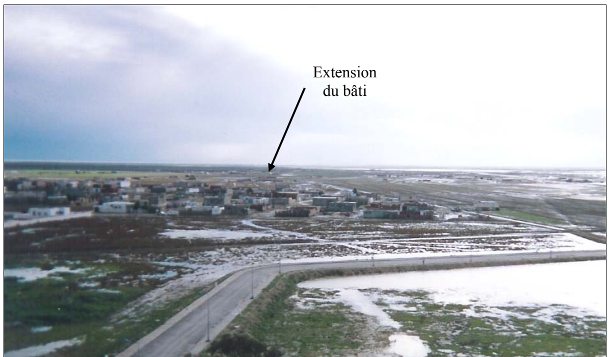
Photo n°30 : Extension du bâti dans les secteurs inondables à Kalaât Landalous. (HABANE A., 2004)
