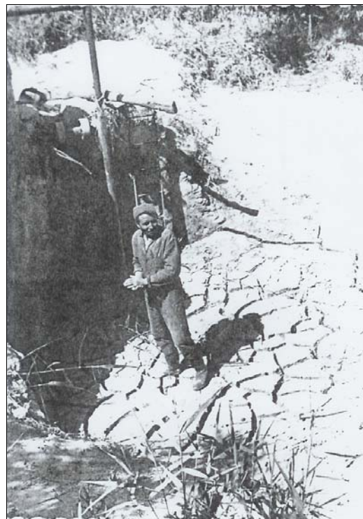
Photo n°33 : Puits colmaté par les alluvions de la crue de mars 1973 (cliché LOYER, mai 1973, in HABANE A., 2004)
