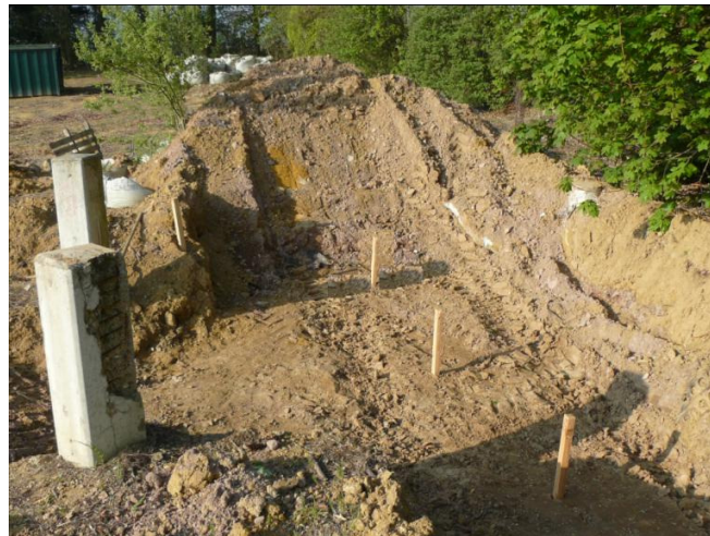
Figure V-3. Implantation des 3 sondages dans la zone retenue
