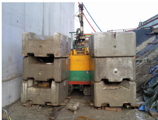
Figure III-4. Réaction assurée par des blocks de béton sur un remblai
