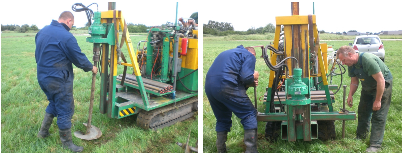
Figure III-3. Installation de la structure de réaction
