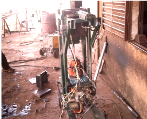
Presse hydraulique en construction chez ADMGA
