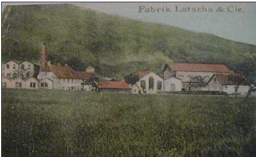
Fig. 48. Latscha & Cie : l'usine centrale (col. B. Risacher)
