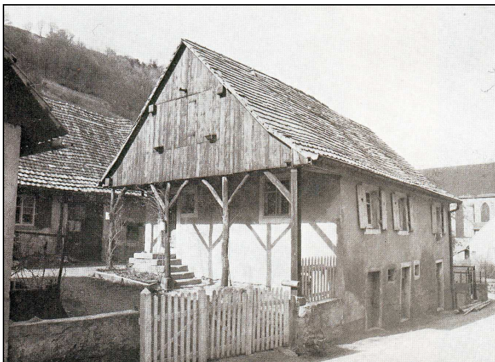
Fig. 83. Maison n°20 rue Principale à Rimbach. La cave et l'étable se trouvent dans l'étage en soubassement et le logement en rez-de-chaussée surélevé. Dans le comble se trouvait le fenil en avancée sur le mur pignon. Le pignon tout entier est en pan de bois lambrissé de planches. (photo, Ministère des affaires culturelles, Inventaire général des monuments et des richesses artistiques de la France. Commission régionale d'Alsace. Haut-Rhin. Canton de Guebwiller , Tome 2, Imprimerie Nationale, Paris, 1972, p. 404).
