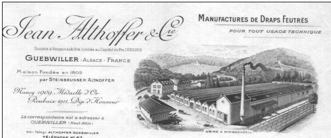
Fig. 63. En-tête de la manufacture Jean Althoffer, (source Philippe Althoffer). L'usine de Rimbach avait une superficie de 3000 m 2 . On voit au 1 er plan à droite les rames qui servaient au séchage et au blanchiment du tissu. Au second plan, à droite, l'usine à toiture en sheds avec, incrustée dans le bâtiment, la centrale vapeur. A gauche, un entrepôt et les écuries. A l'arrière plan, la « Cité », l'habitat collectif des ouvriers. (col. Ph. Althoffer)
