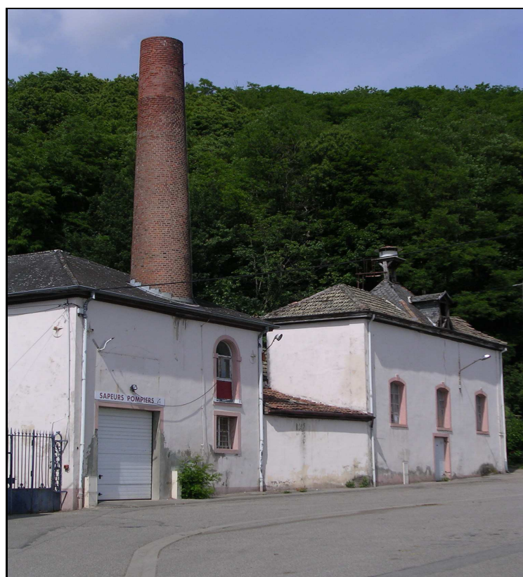
Fig. 04. L'usine du bas à Jungholtz (photo B.Risacher)
