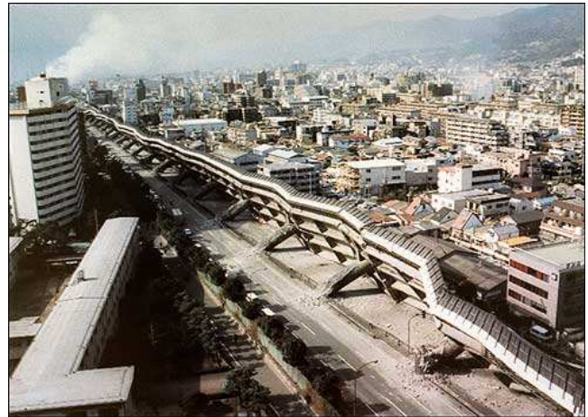
Figure 1-7 : Rupture en flexion des piles de pont de la Hanshin expressway (Kobe, 1995).
