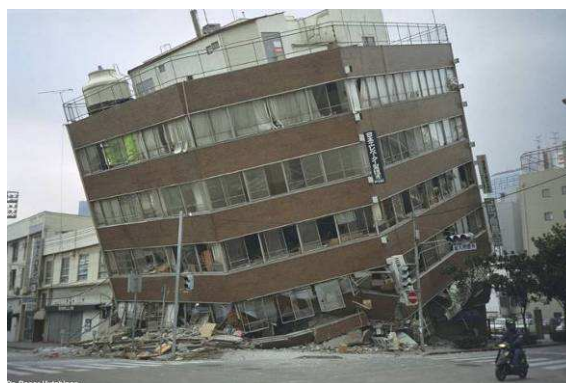
Figure 1-3 : Effondrement de l'étage inférieur du bâtiment (Kobe, 1995).
