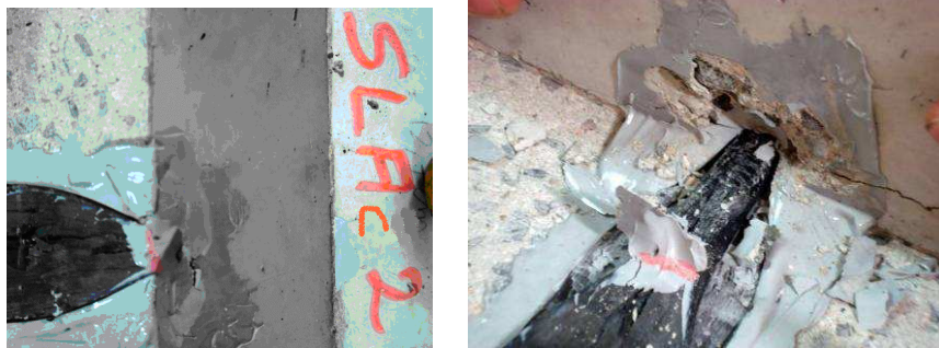
Figure A3- 6 : sortie progressive de la partie ancrée de la lamelle - essai SLAc2
