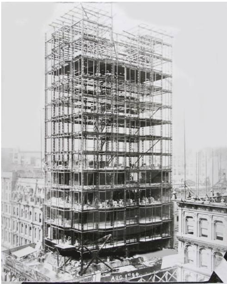
271 - Louis Sullivan, le Carson, Pirie, Scott & Co. en construction, Chicago, 1894
