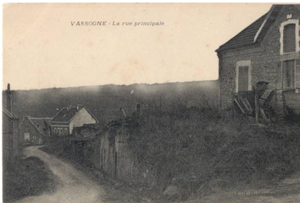
Doc 83 : la maison de l'entrepreneur Maroteaux-Cabaret vers 1922. On notera la présence d'un crépi et d'un toit en tuilettes plates (aujourd'hui tuiles mécaniques H14) 757
