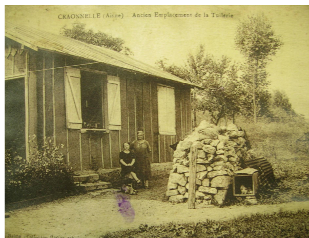
Doc 34 : une autre semi-provisoire de type S.T.P.U. et recouverte de carton bitumé à Craonnelle 250
