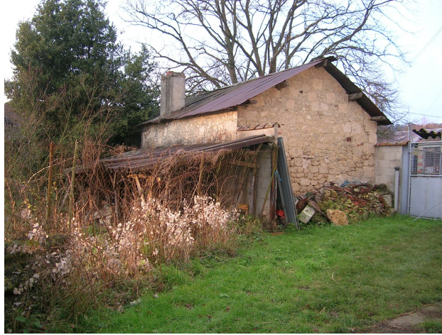
Doc 43 : une semi-provisoire servant de remise, Vassogne 277
