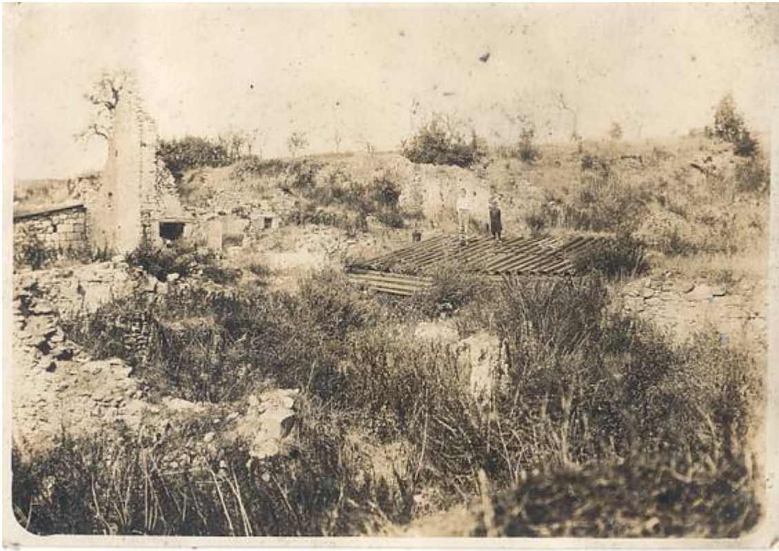
Doc 37 : attendre sa semi-provisoire : provisoire enterrée recouverte de tôles métró à Oulches ; gamins sur la toiture, 1919-1920 262
