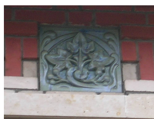
Doc 120 : détail de la façade de la mairie-école de Chevregny : faïence à décor végétal art-déco 817
