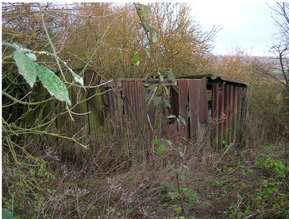
Doc 32 : vestige à Vassogne des premières provisoires en matériaux de récupération (les grosses tôles à l'avant du bâtiment sont des « métros » 232 )
