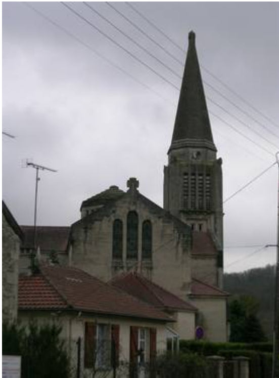
Doc 49 : église d'Aizy-Jouy, clocher en béton armé, sans doute le plus osé du Chemin des Dames 466
