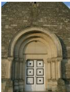
Doc 110 : le porche d'entrée de l'église de Vassogne mettant en perspective des figures géométriques 804
