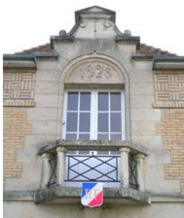
Doc 67 : façade de la mairie-école de Vassogne datée 1928, construction de l'entreprise Maroteaux-Cabaret, architecte Daniel Beylard 633
