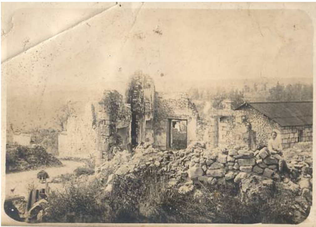
Doc 40 : semi-provisoire en moellons de récupération fraîchement jointoyés à Oulches dans les ruines ; tas de pierres au premier plan ; un gamin pose ; vers 1920 265
