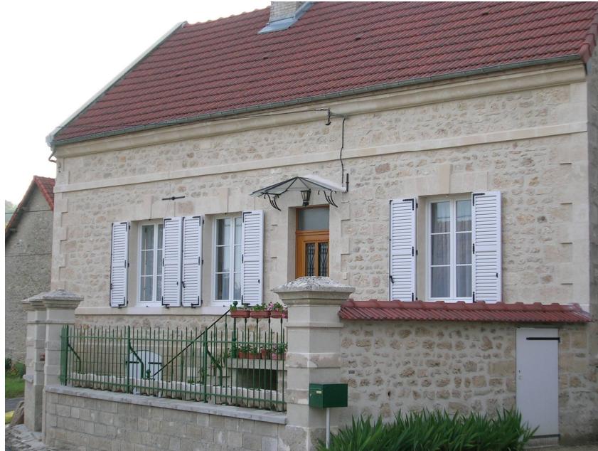
Doc 69 : maison de l'oncle Maroteaux puis de Jules Emile Cabaret. Façade tout en pierre alternant des bandeaux de pierre de taille et moellons. Noter la corniche et les chapiteaux de façade 660
