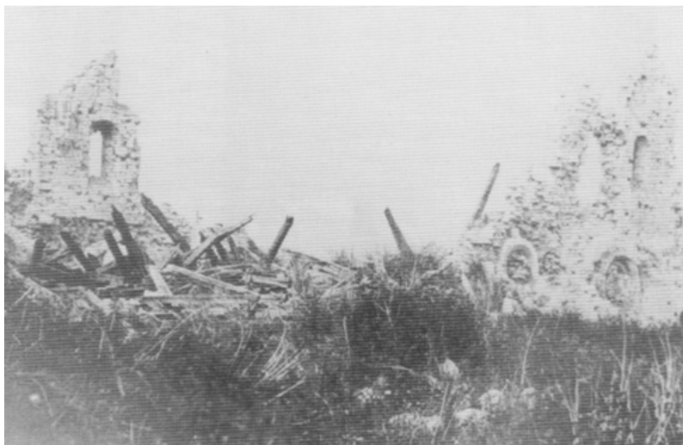
Doc 127 : Vaclair en 1918, la même façade est du bâtiment des converses 830
