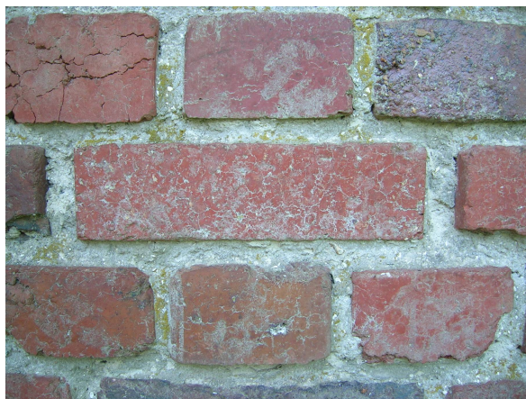
Doc 142 : brique rouge, non marquée (provenance inconnue). Sur un mur de grange. Probablement un modèle de brique déclassé et donc moins onéreux à l'achat 863
