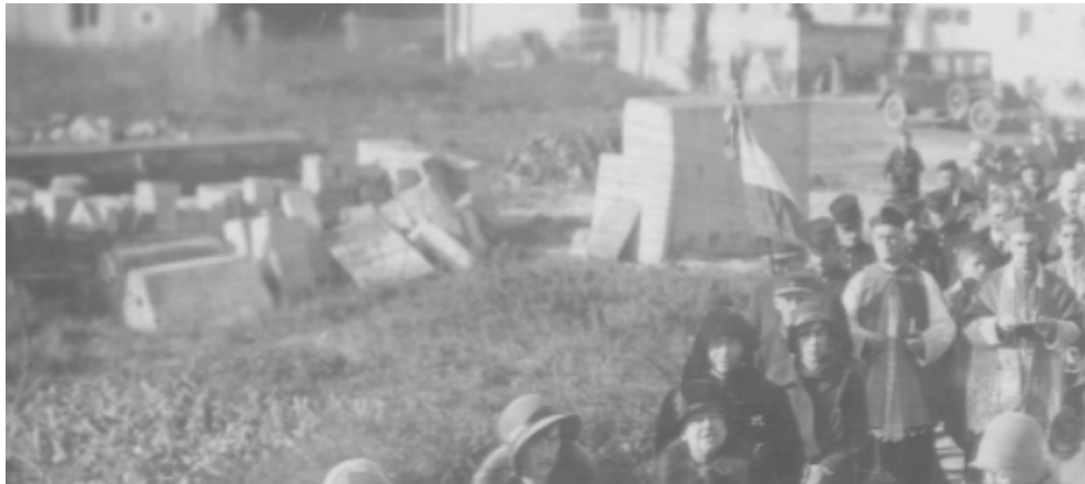
Doc 148 : aire de découpe de la pierre sur la commune de Vassogne. Le bloc descendu de la carrière de pierre est débité en morceaux adaptés aux constructions appelés parpaings. Entreprise Maroteaux-Cabaret 879
