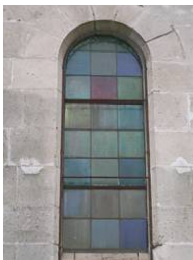
Doc 107 : vitraux de l'église d'Aizy-Jouy composés d'un assortiment de verre de couleurs variées montés de façon géométrique 801
