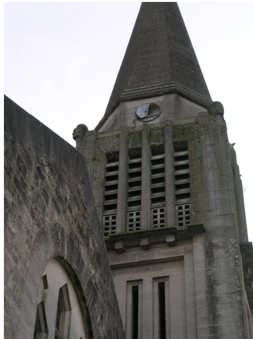
Doc 106 : clocher de l'église d'Aizy-Jouy alternant pierre de taille et béton armé 800
