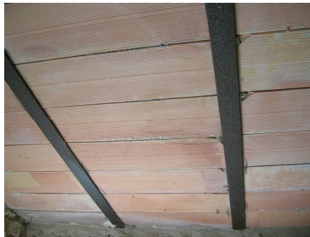
Doc 155 : structure porteuse de la dalle en béton vue du dessous. Porteurs IPM et briques creuses. Au dessus béton. Modèle à simple porteur ici 894
