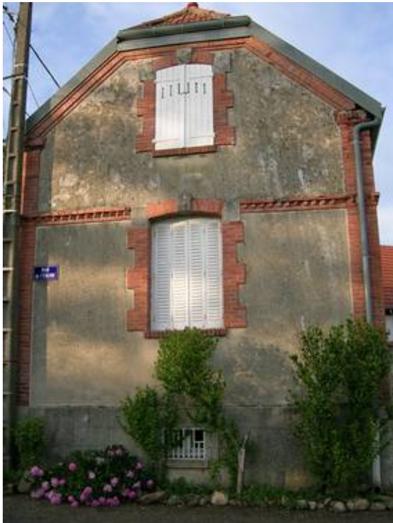
Doc 77 : une maison à appareillage de brique rouge (DZ) et moellons recouverts d'un enduit 750
