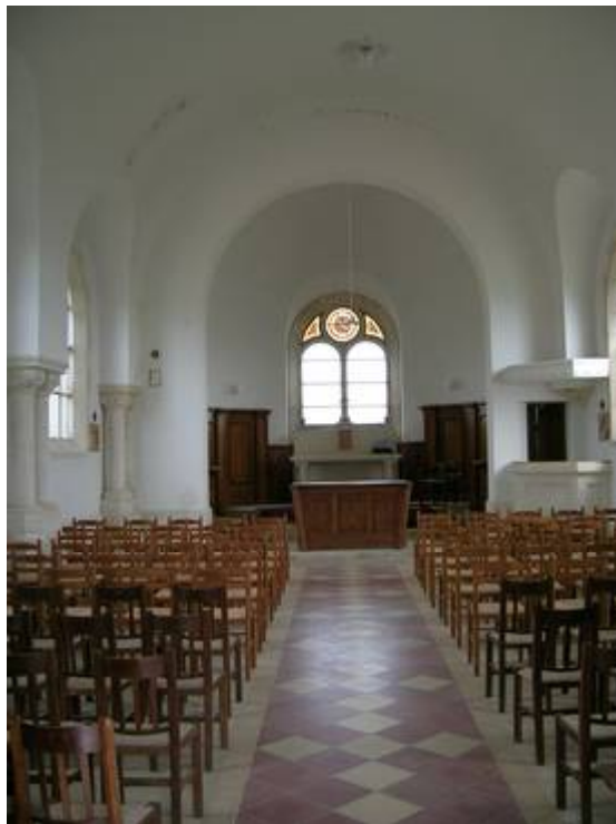
Doc 112 : intérieur de l'église de Vassogne : mur recouvert de plâtre, voute en plâtre, chapiteaux en pierre, boiseries dans le cœur 805
