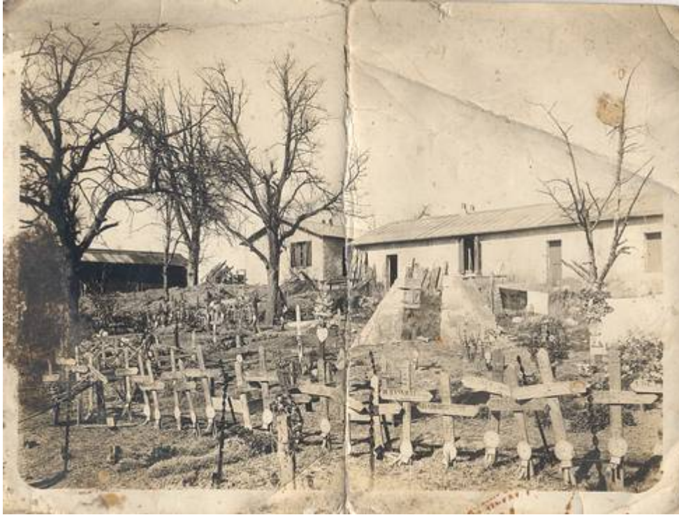
Doc 39 : vivre à Oulches au milieu des morts ; semi-provisoires en L en arrière plan ; bois récupérés dans les décombres le long des maisons ; linge qui sèche au pied d'un arbre mort ; vers 1920 264
