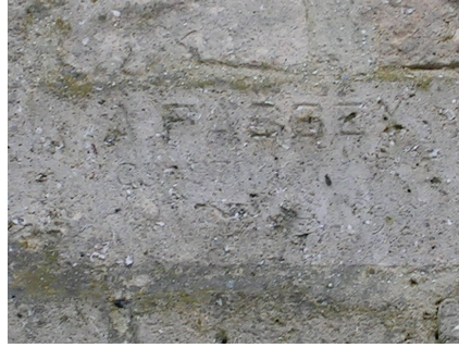
Doc 151 : signature d'entreprise « A. FASSEY » (?) dans le mur de la ferme Chrétien à Vassogne. Héritage d'une tradition des constructeurs 884
