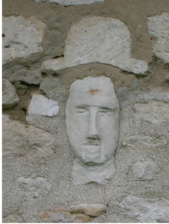
Doc 150 : tête et chapeau dans le mur de la maison Joly à Vassogne. Œuvre de tailleur de pierre, entreprise Maroteaux-Cabaret 883
