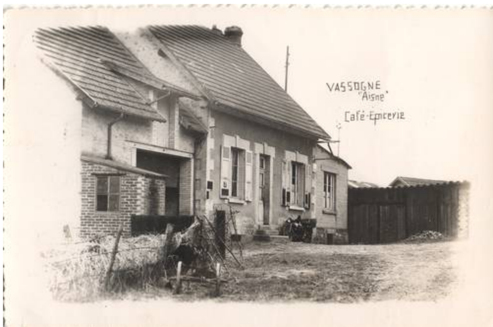
Doc 84 : café épicerie de Vassogne, maison Hautemont. Construction de la maison centrale en premier, du bâtiment de gauche en second et d'un rajout en brique jaune à droite de la maison en dernier (fin des années 30) 760
