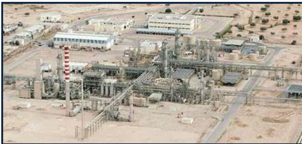
Photo. 1 Champs aérien de L'usine de traitement de Gaz Hannibal
