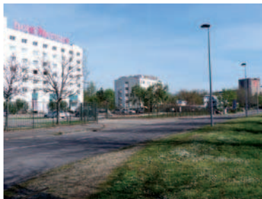
Infrastructures hôtelières. En arrière-plan, les bureaux de la CDC.
