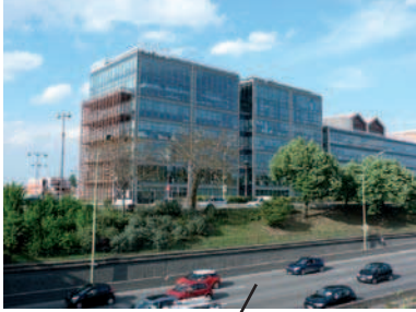
Le boulevard périphérique au niveau de la Porte d'Aubervilliers. De l'autre côté, le siège social d'Icade.
