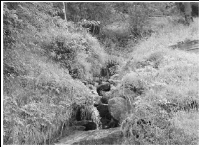
A. Hérémece, torrent de Tzénaz avant travaux
