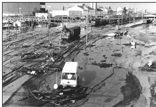
B. Inondation de la gare CFF, dans la partie aval du cône, lors de la crue de la Sionne en juillet 1992 089ph-00719
