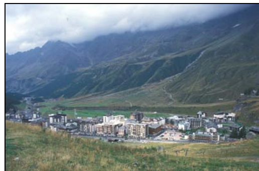
C. La grande digue paravalanche de Breuil, septembre 2003
