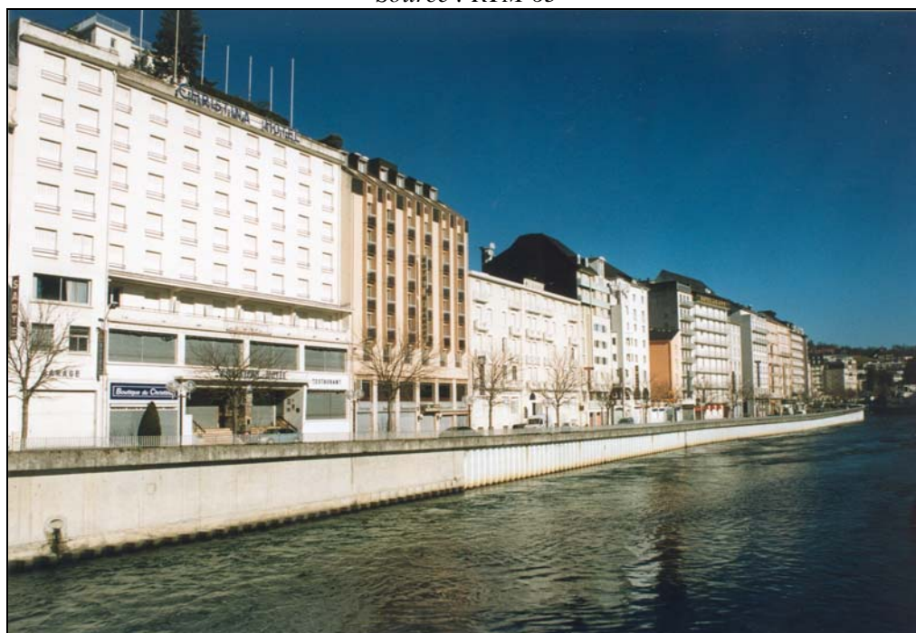
B. Lourdes : les hôtels situés en zone inondable sur la rive gauche du Gave de Pau (23 février 2003)
