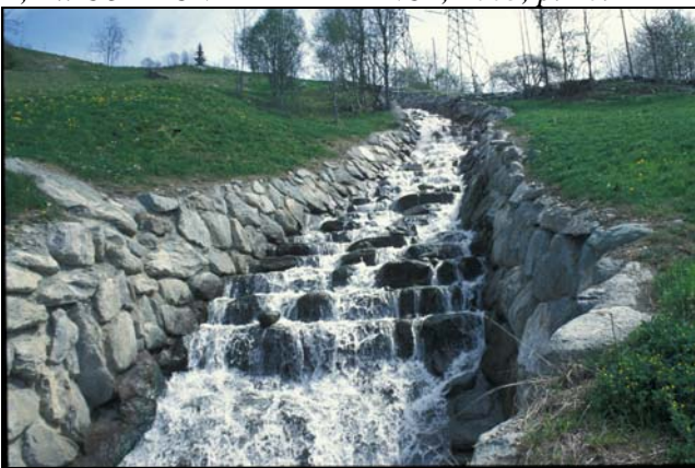
C. Torrent de Verbier après les travaux suite aux crues d'octobre 2000, 25 avril 2003
