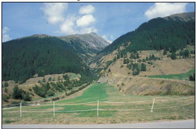
D. Reckingen, Val de Conches, diges paravalanches, 27 août 2003
