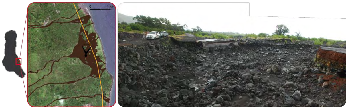
Figure 90 - Route détruite par une coulée de débris sur la côte est de la Grande Comore, au nord de Pidjani et photo-interprétation des lahars sur la zone à partir de Google Earth (clichés J. Morin, avril 2007 ; fonds de carte Google Earth 2009 ; date de l'événement inconnue)
