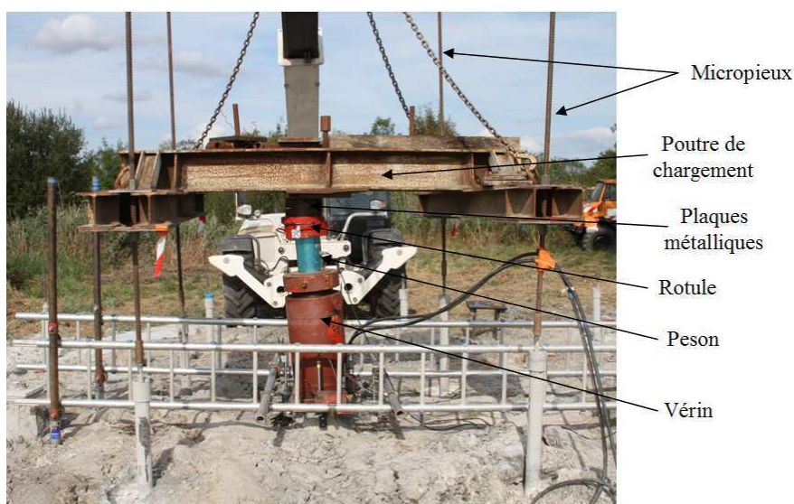
Figure IV-68. Essais de chargement du pieu n°2 – Cubzac-les-Ponts
