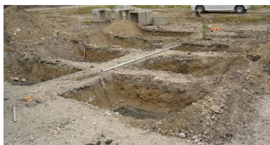
Figure IV-27. Décaissement de la couche de remblai
