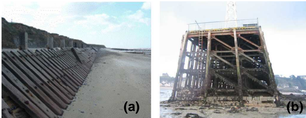
Figure I-7. Ouvrage de protection littoral en Angleterre (a) et jetée de la Fenêtre à Cancale en Ille-et-Vilaine (b)
