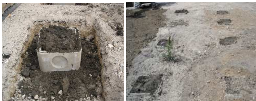
Figure IV-29. Remblaiement des regards en béton
