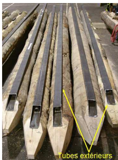
Figure IV-9. Fixation des tubes extérieurs métalliques à section carrée dans la saignée
