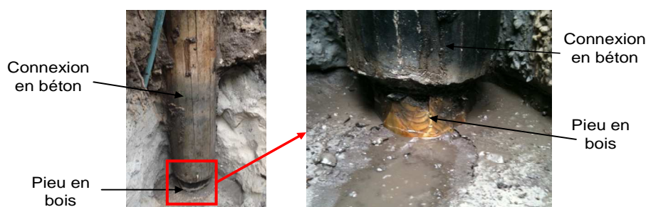
Figure II-43. Pieu en bois et connexion en béton
