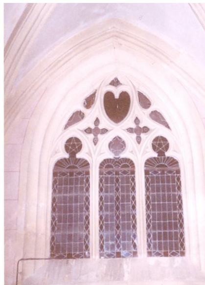
Figure 166: Vindecy, église paroissiale, chapelle seigneuriale (chapelle Le Viste). Paroi orientale : emplacement du vitrail de Jean Le Viste IV, début XVI e siècle.
