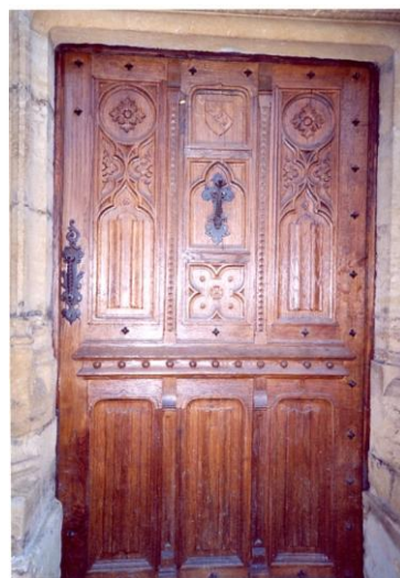
Figure 158: Château d'Arcy, porte d'entrée, en bois sculpté aux armoiries Le Viste
