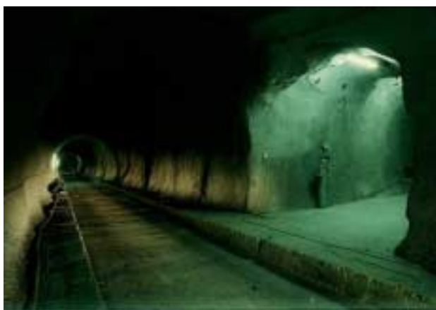
Figure 8.6 : Niche de la galerie de reconnaissance du tunnel du Mont Terri, d'après Thury et Bossart, 1999, [126]
