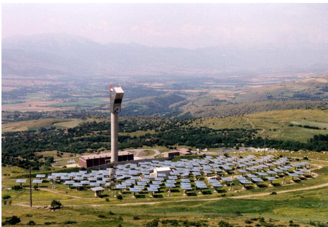
FIG. 1.1 – Le site de Thémis. Face à la tour (100 m de hauteur) de l'ex-centrale solaire apparaît le champ des 200 héliostats (54 m 2 de surface individuelle). Au centre, le hangar blanc abrite le télescope CAT.
