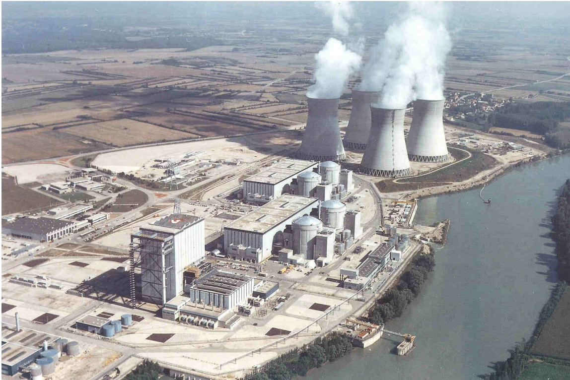
Figure 2.2: La centrale de production nucléaire du Bugey
