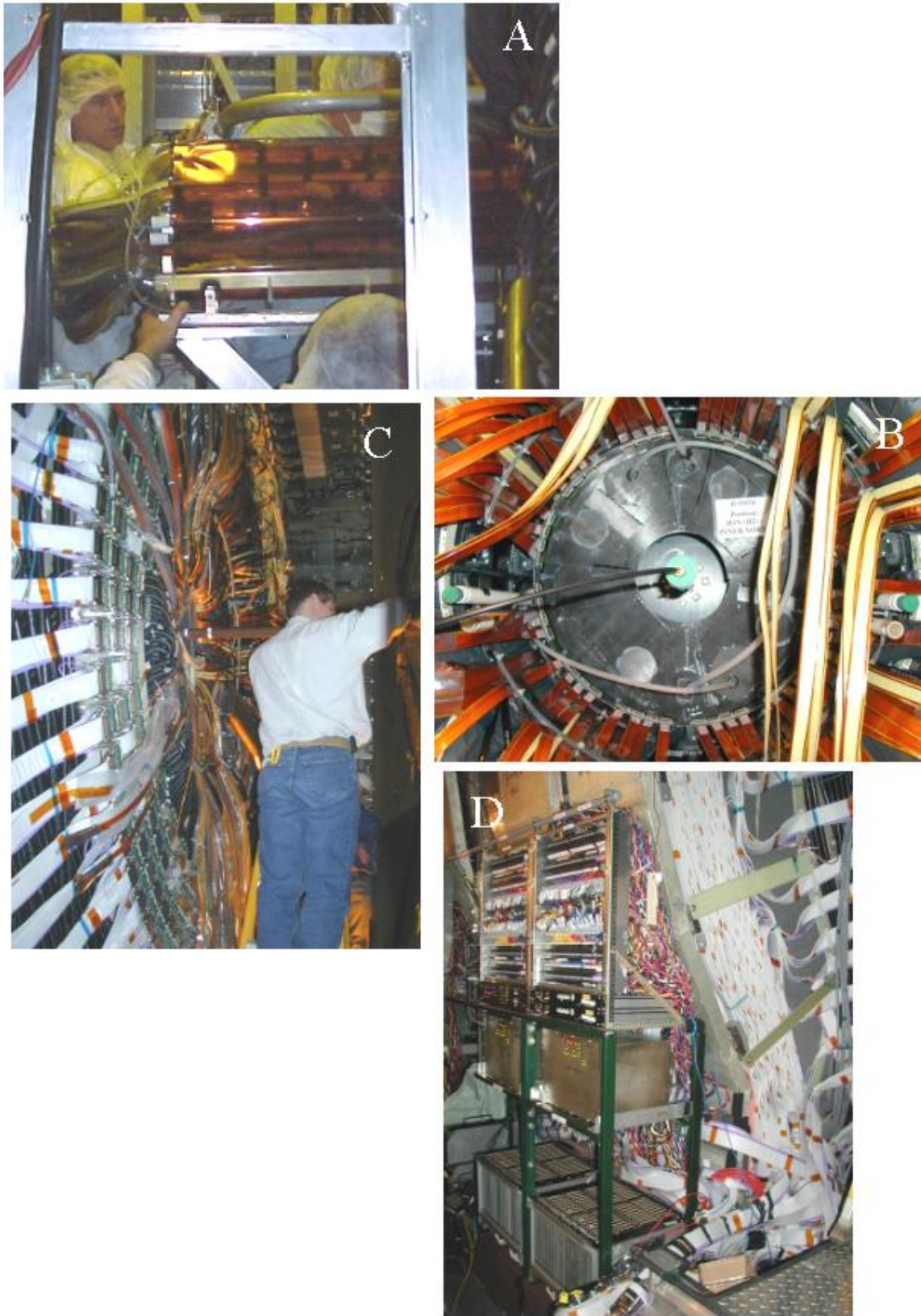
Figure 6.39: Etape de l'installation de la moitié du SMT
