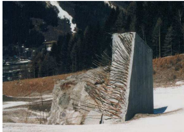
Photo 1.5: - Dent déflectrice endommagée - Taconnaz (Haute-Savoie) (photo C. Ancey)
