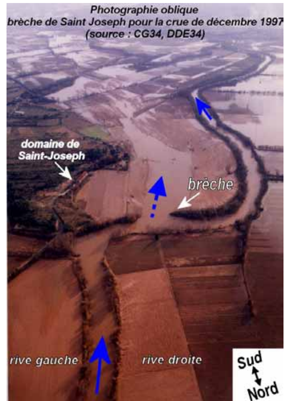
Figure 13-5 : brèche dans la digue de protection du domaine "Saint-Joseph", structure importante pour la répartition des eaux entre rive droite et rive gauche
