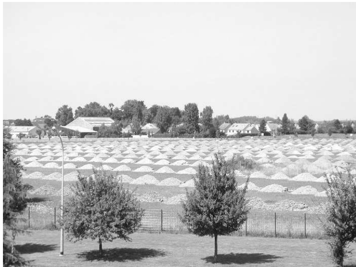
FIG. 1.1 – Fouilles archéologiques sur le futur emplacement du synchrotron Soleil : les tas de terre extraits forment des cônes remarquablement reproductibles d’angle voisins de 30^\circ .
