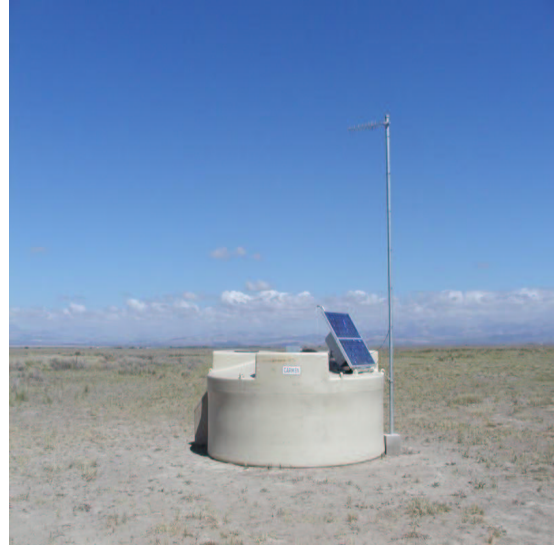
(b) Photo d'une cuve installée en Argentine dans la Pampa.
