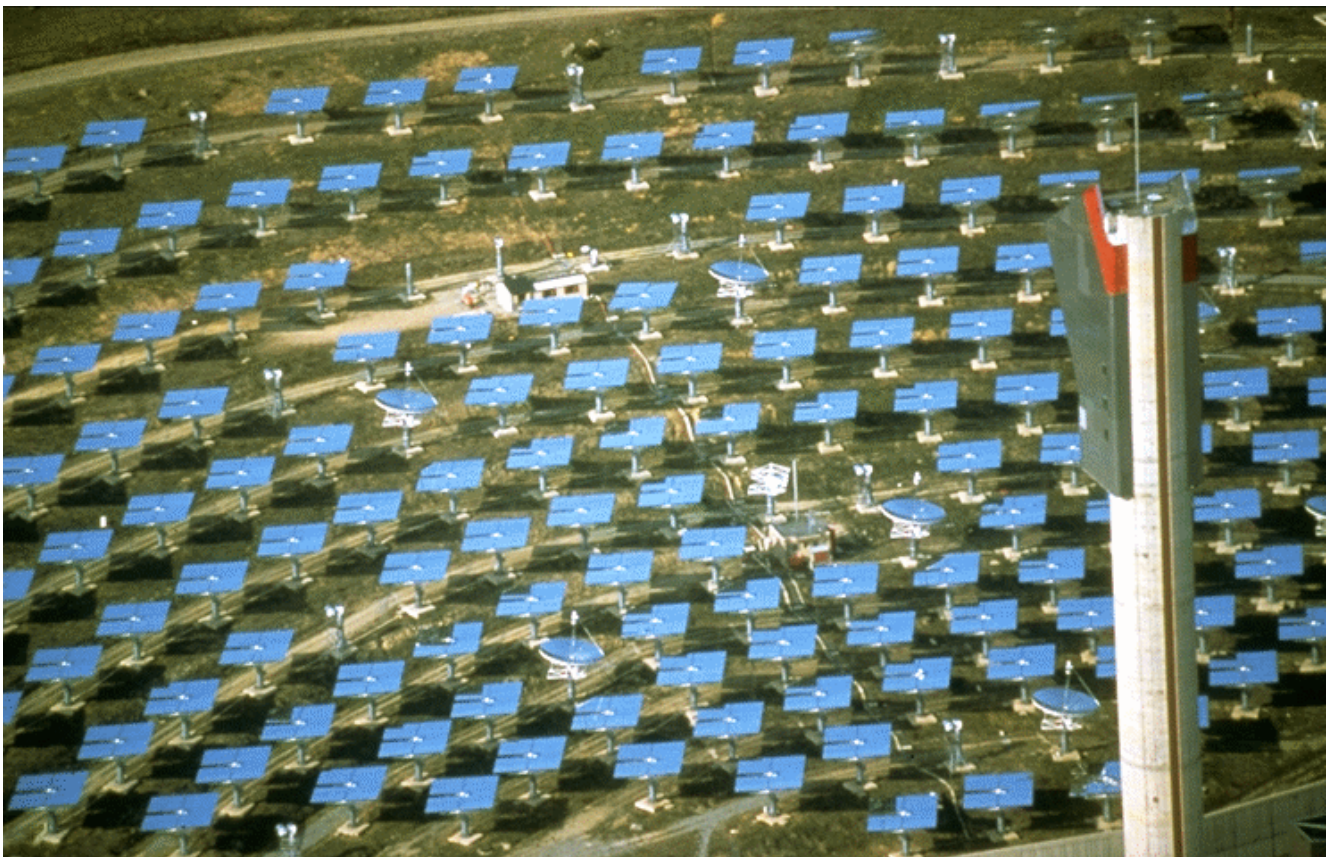
FIG. 5.1: Vue générale de la ferme solaire et des héliostats utilisés par CELESTE.
