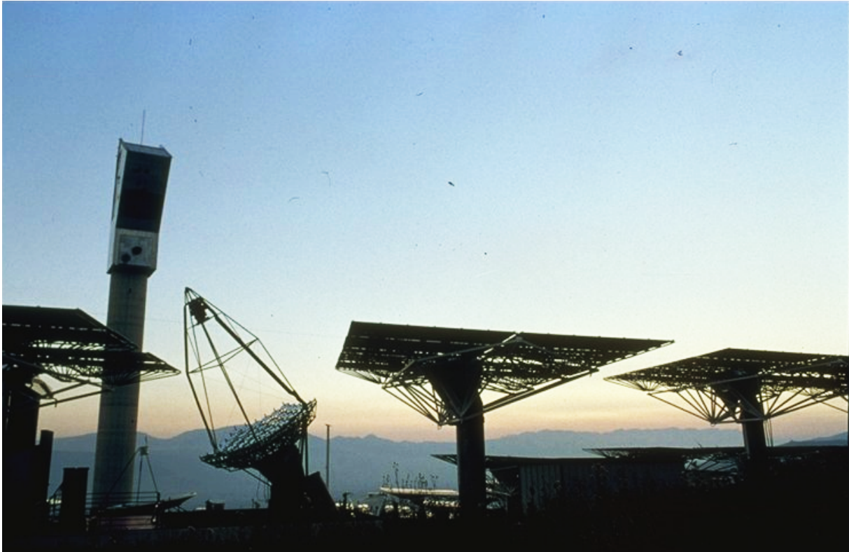
FIG. 1.12: Photographie du champ de Thémis ( 42.5^\circ N, 2^\circ E et 1650 m d'altitude) dans les Pyrénées Orientales. On distingue au centre l'imageur CAT, entouré des héliostats de la ferme solaire, héliostats réutilisés par CELESTE.
