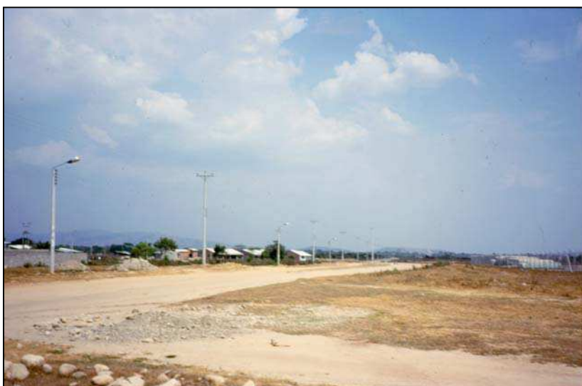
Vue 6 - Tauramena. La Primavera , quartier de logement social. Maison de deux pièces vendues en gros œuvre, sans possibilité d'agrandissement. Beaucoup n'ont pas trouvé d'acquéreur. A droite : extension prévue.
