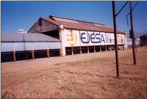
Vue 24 - Bâtiment ferroviaire loué à une entreprise privée. Gare centrale (Jujuy)
