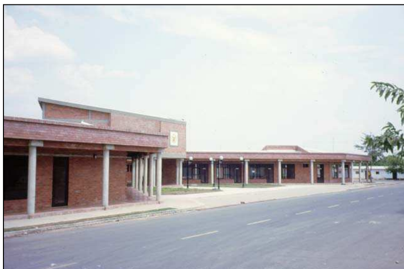
Vue 9 - Tauramena. Gare routière. Achevée mais éloignée du centre et surdimensionnée, elle n'est pas entrée en service. Les locaux commerciaux sont entièrement vides
