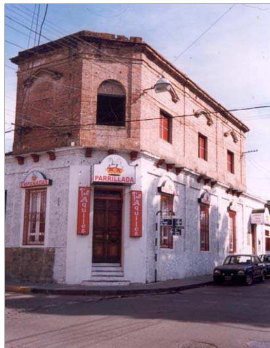
Vue 8 - Ancien restaurant Livia. Bâtiment classé en pierre et en brique. Exemple de restauration non conforme à la réglementation (Jujuy)
