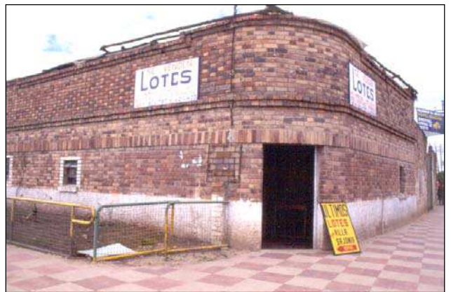
Vue 9 - Madrid. Vente de terrains ("lotes") pour l'auto-construction de logements populaires, sans doute illégalement (quartier "pirata").
