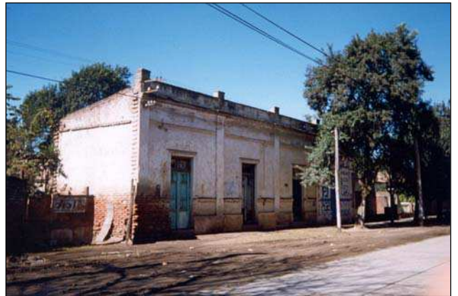
Vue 20 - Ancien logement ouvrier des chemins de fer (Tafi Viejo)
