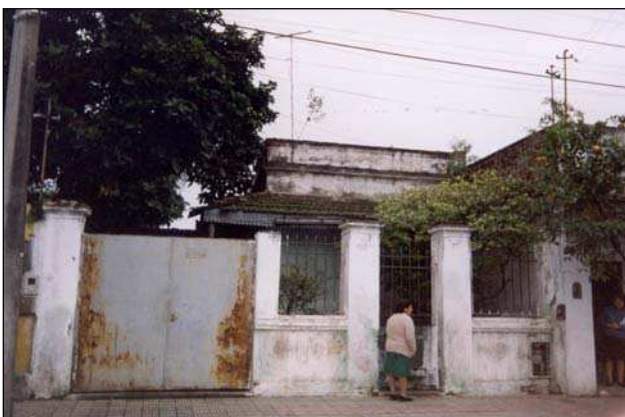
Vue 19 - Ancien logement de cadre des chemins de fer. Station Belgrano (Tucuman)
