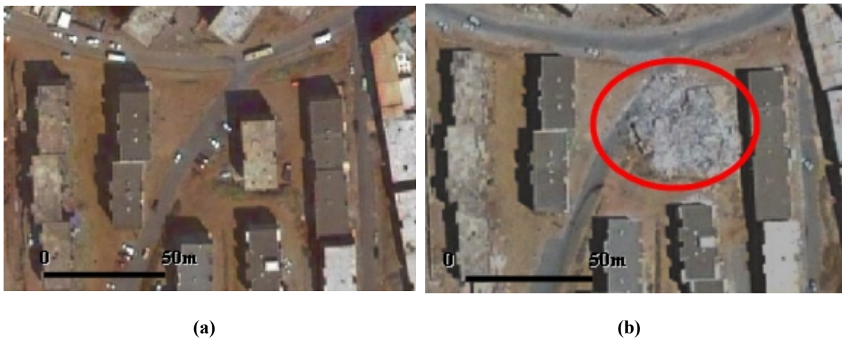
Figure 4.42 Endommagement très important à Boumerdes. L'immeuble à l'intérieur du cercle rouge a été complètement rasé. L'image prise avant le séisme (a), et celle acquise deux jours après (b) (source image : DigitalGlobe).
