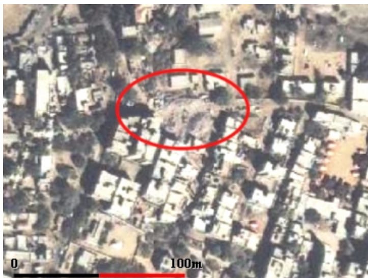
Figure 4.24 Constructions en ruine, dont les débris couvrent la route, suite au séisme de Bhuj du janvier 2001
