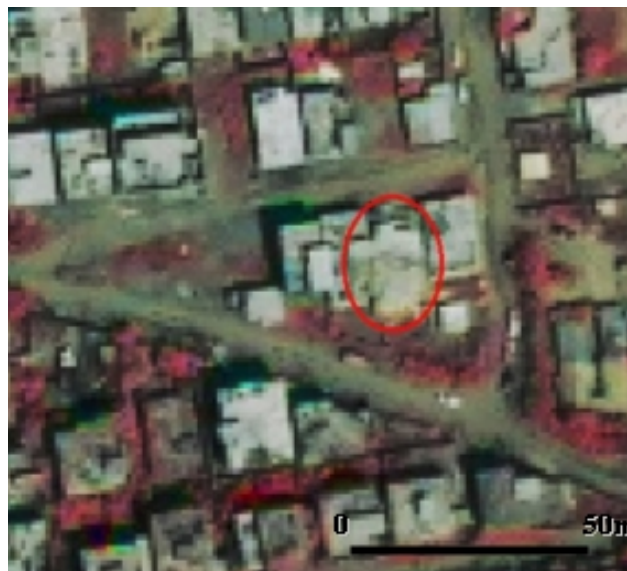
Figure 4.34 Reconnaissance des dommages suite au séisme de Boumerdes, de mai 2003, à l'aide d'une image IKONOS post – événement. On remarque l'absence de l'ombre du bâtiment situé dans le cercle rouge (source image : European Space Imaging).
