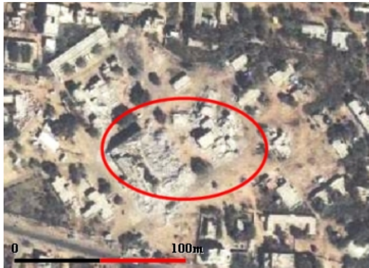
Figure 4.23 Ensemble des bâtiments complètement détruits sur la ville de Bhuj, suite au séisme du janvier 2001
