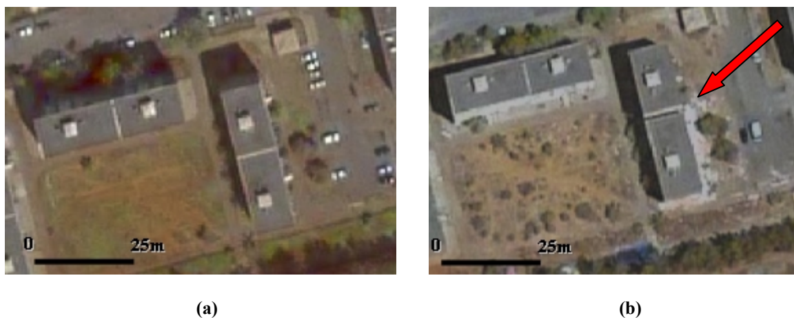
Figure 4.40 Effondrement d'un rez-de-chaussée à Boumerdes, détectable à l'aide de l'imagerie multi-temporelle. L'image prise avant le séisme (a), et celle acquise deux jours après (b). (source image : DigitalGlobe).
