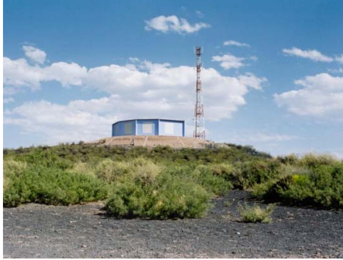
FIG. 2.7 – Le bâtiment de fluorescence à Los Leones où ont été installés les deux télescopes du réseau prototype. On voit également la tour de communication qui sert de relais pour transmettre les informations au système d’acquisition central.
