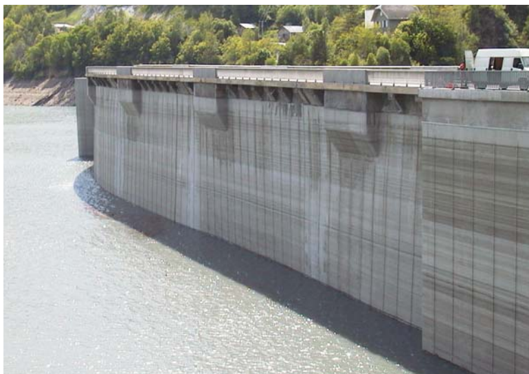
Figure 5 : vue du parement amont du barrage du Chambon et de la membrane étanche
