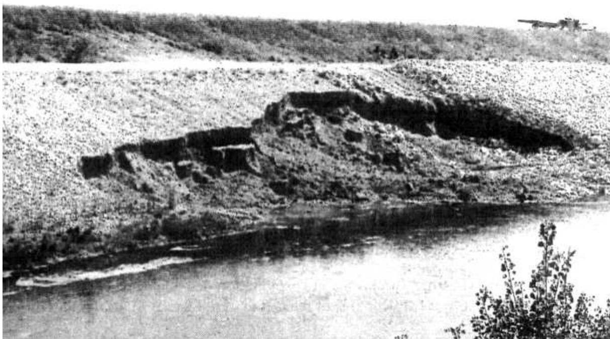
*figure 2-18, Exemple de rupture de talus aval (Brun, 1993)*
