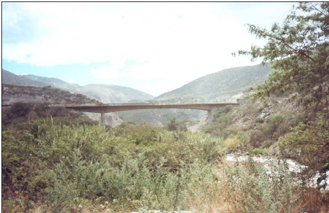
Photo 31 : Pont stratégique pour l'accès nord oriental au DMQ. Pont sur la Panaméricaine Nord au nord-est de Quito enjambant le Río Guayllabamba (Cliché : F. Demoraes – juillet 2002)
