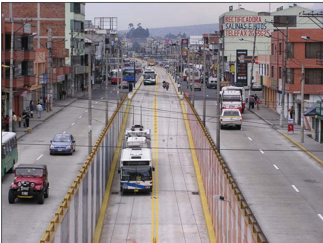
Photo 21 : Avenue Maldonado : axe central de pénétration du sud de Quito. Cette artère correspond à un grand axe de circulation, à l'axe de circulation du trolley et à un corridor majeur des transports en commun urbain et intercantonal (Cliché : F. Demoraes – décembre 2002)
