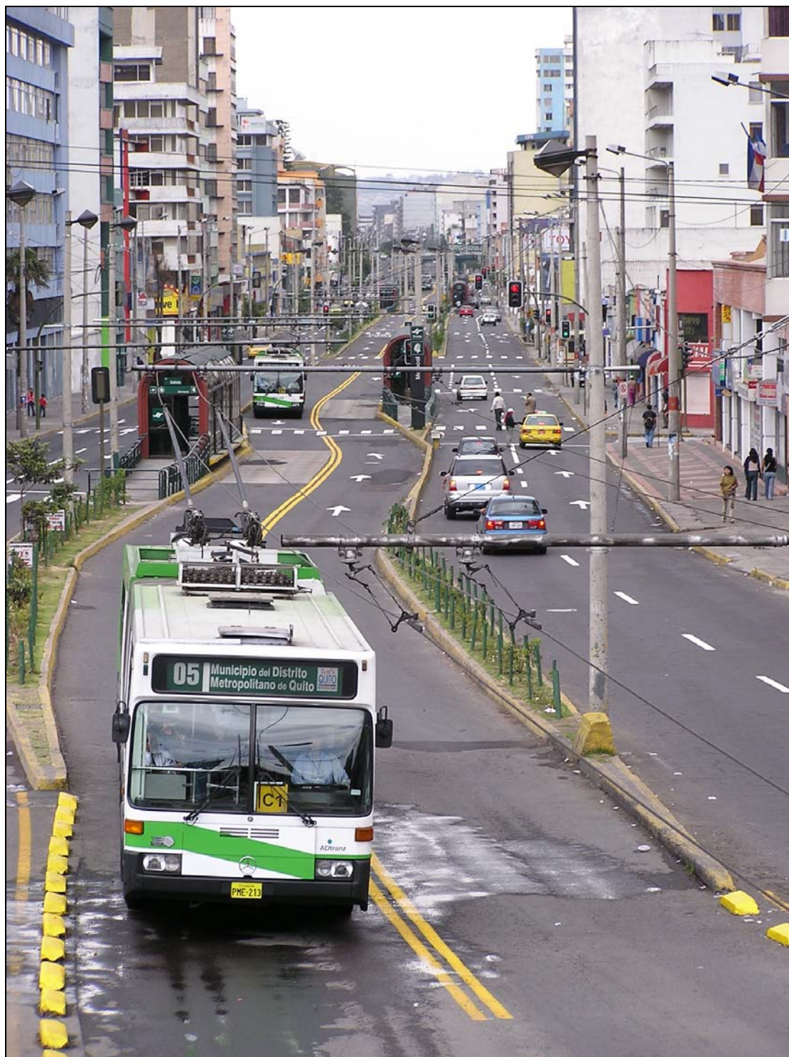
Photo 13 : Voie réservée du trolleybus sur l'avenue 10 de Agosto. Le site propre est situé au niveau de la partie centrale de la chaussée, la circulation automobile étant confinée sur les deux voies latérales. (Cliché : F. Demoraes – décembre 2002)
