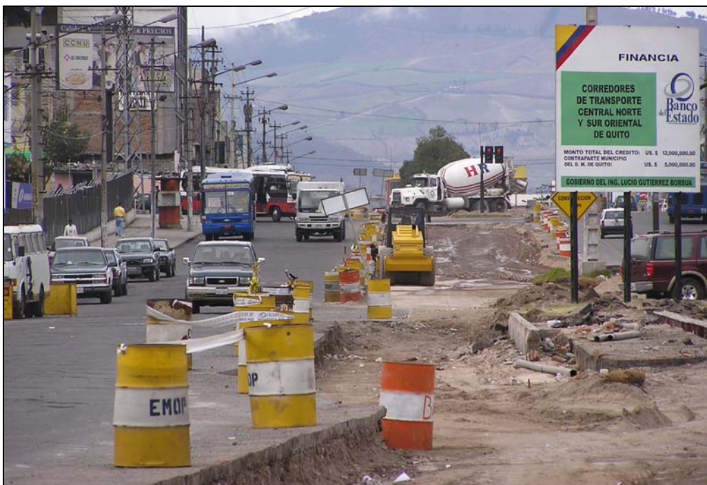
Photo 15 : Site propre en construction sur l'avenue Prensa (Cliché : F. Demoraes, février 2004)
