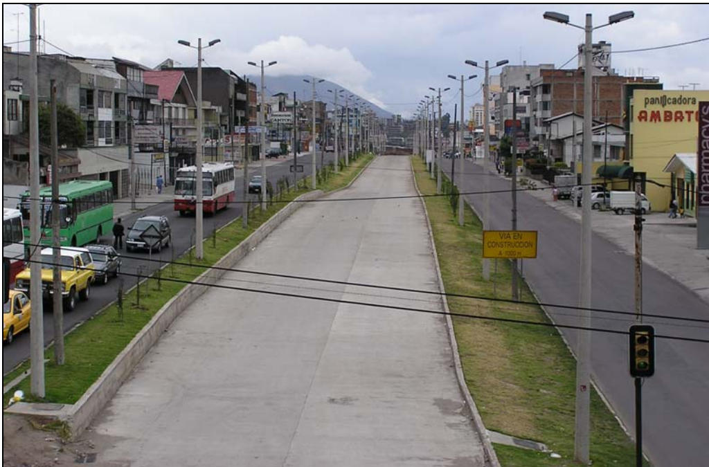
Photo 14 : Site propre en construction sur l'avenue América (Cliché : F. Demoraes, février 2004)
