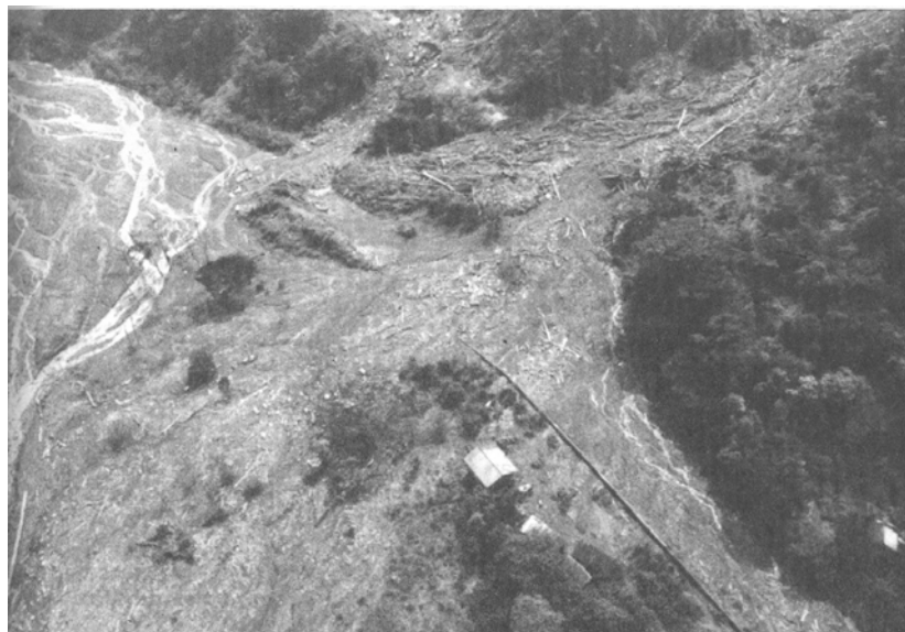
Photo 36 : Rupture de l'oléoduc et de la route entre Baeza et Lago Agrio. La rupture s'est produite à cause d'un glissement de terrains activé par le tremblement de terre du 5 mars 1987 (Hall M., 2000).
