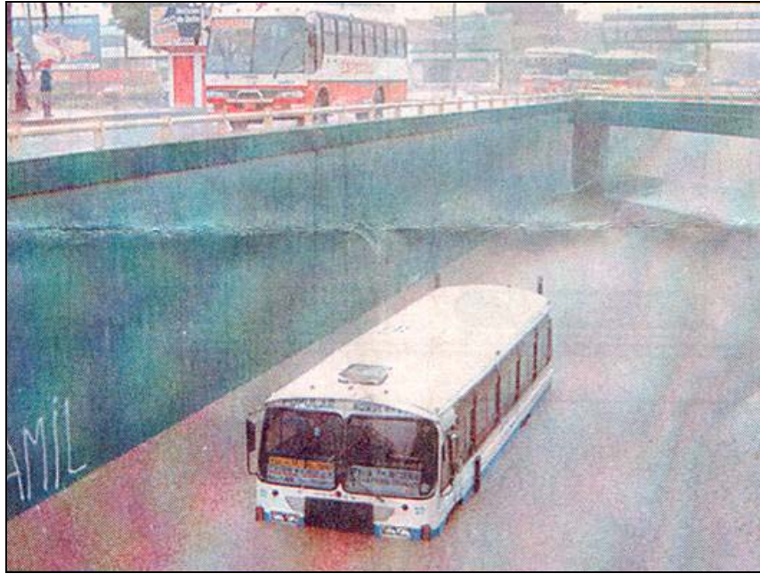
Photo 53 : L'enneiement d'un passage surbaissé au niveau de l'aéroport. Certaines constructions favorisent l'apparition de phénomènes qui perturbent la circulation. ( El Comercio – mars 2000 ).
