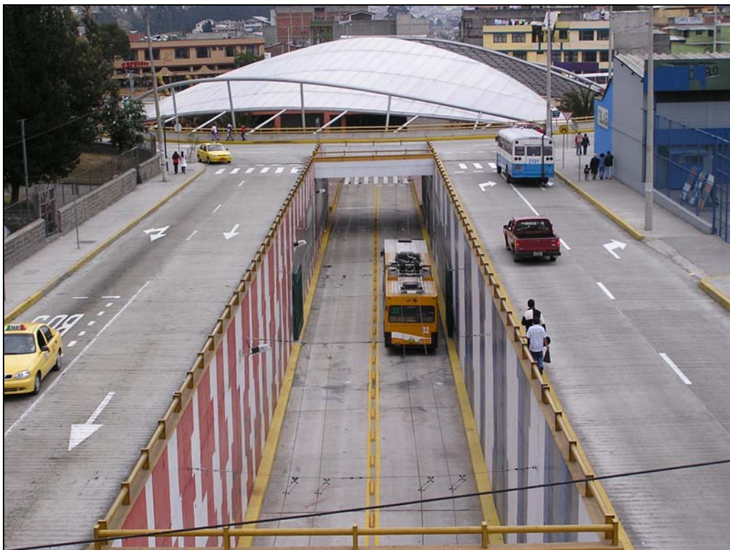
Photo 6 : Nouvel échangeur de la Villa Flora.
