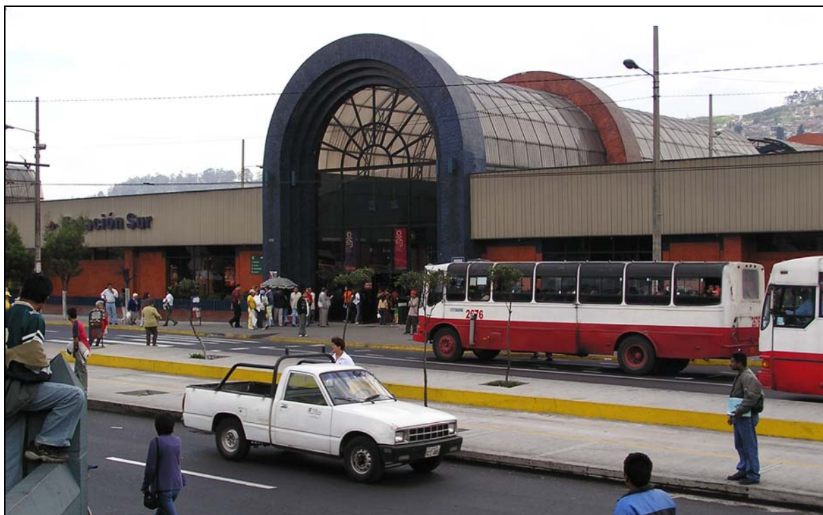
Photo 11 : Station Sud El Recreo .
