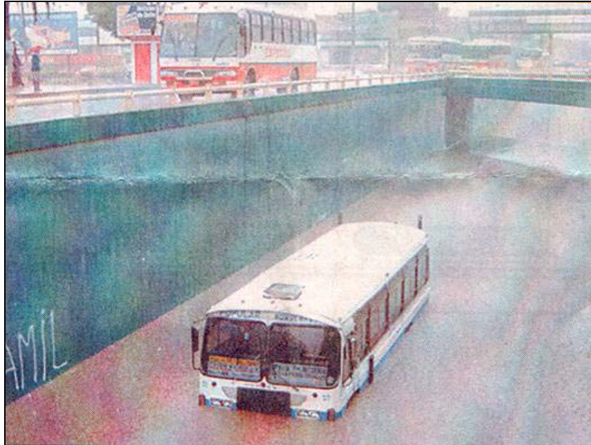
Photo 53 : L'enneiement d'un passage surbaissé au niveau de l'aéroport. Certaines constructions favorisent l'apparition de phénomènes qui perturbent la circulation. ( El Comercio – mars 2000 ).
