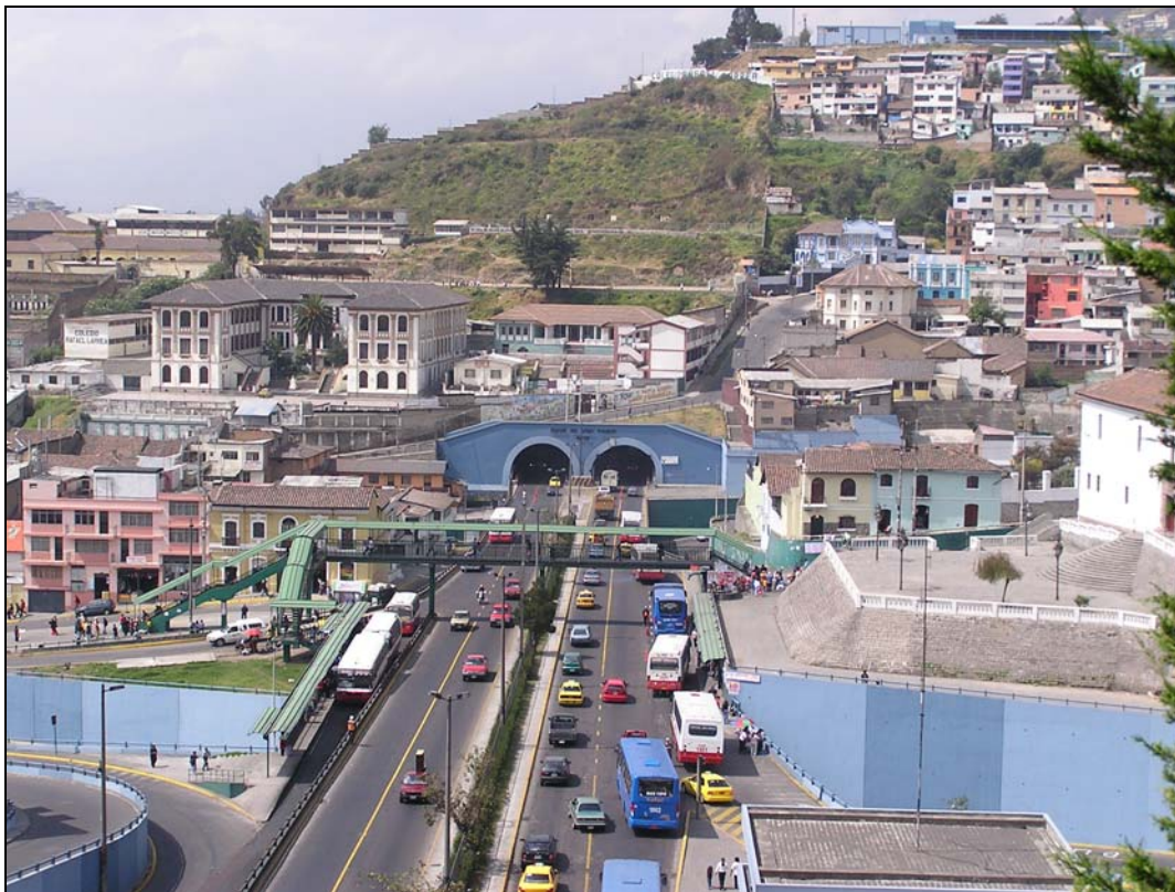
Photo 27 : Avenue Mariscal Sucre entre les tunnels de San Diego et San Roque .
