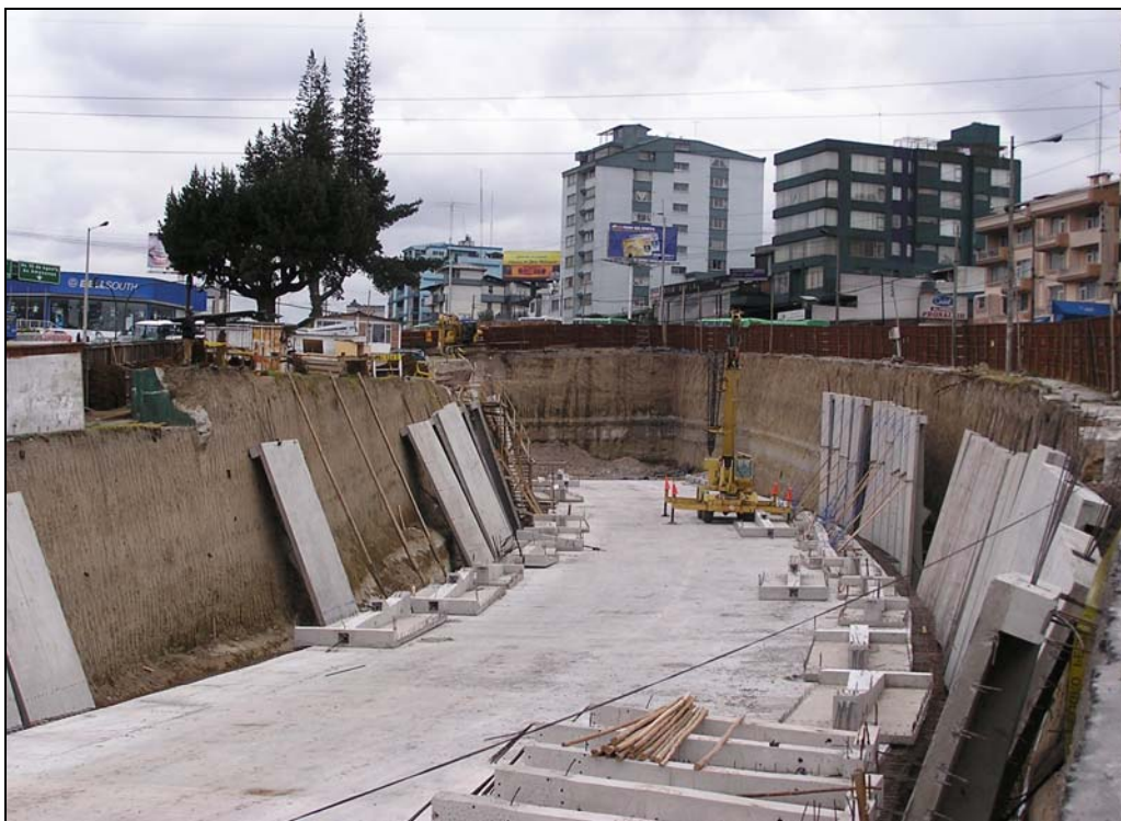
Photo 7 : Construction d'un échangeur à la jonction des avenues América et Naciones Unidas (Cliché : F. Demoraes, février 2004)
