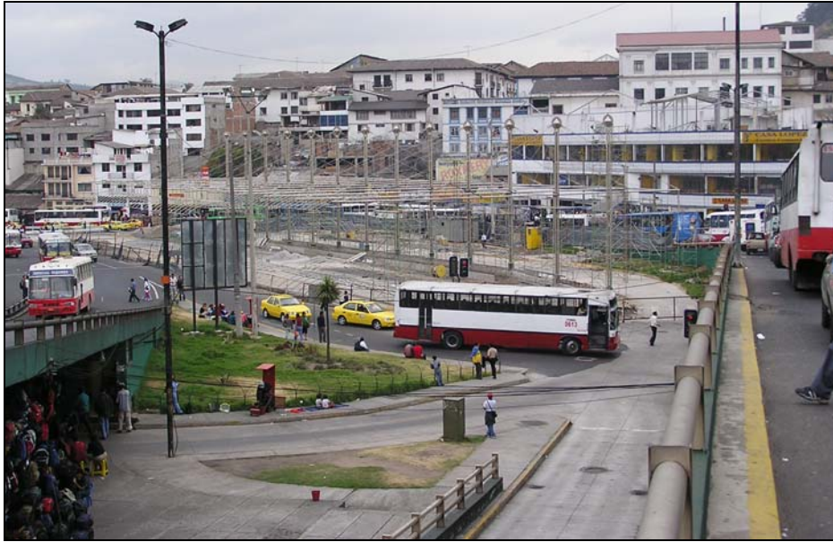
Photo 8 : Construction d'un centre de correspondances à La Marín.
