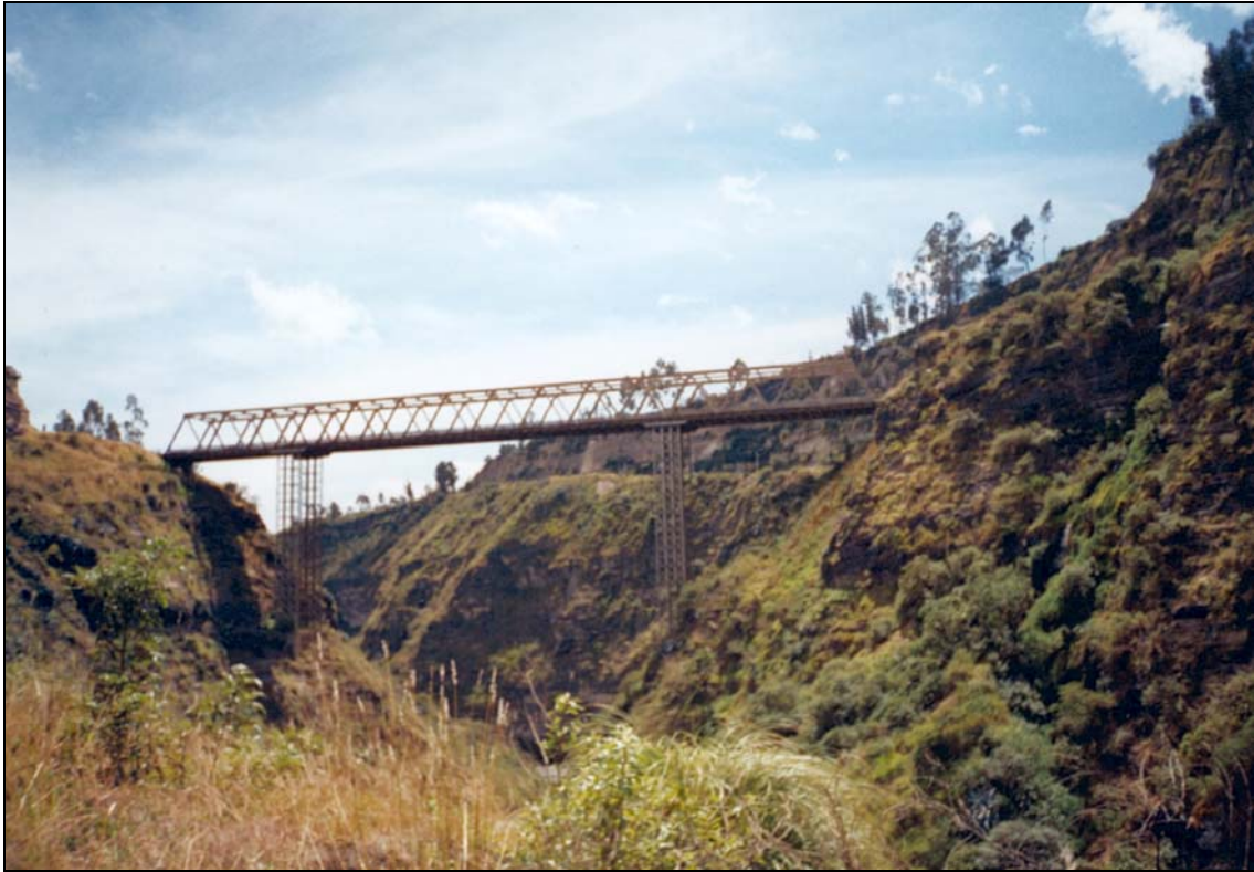
Photo 30 : Pont stratégique pour l'accès oriental au DMQ. Pont métallique enjambant le canyon du Río Chiche entre Pifo et Tumbaco (Cliché : F. Demoraes – juillet 2002)
