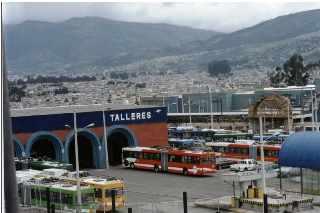
Photo 35 : Station du trolleybus El Recreo.
