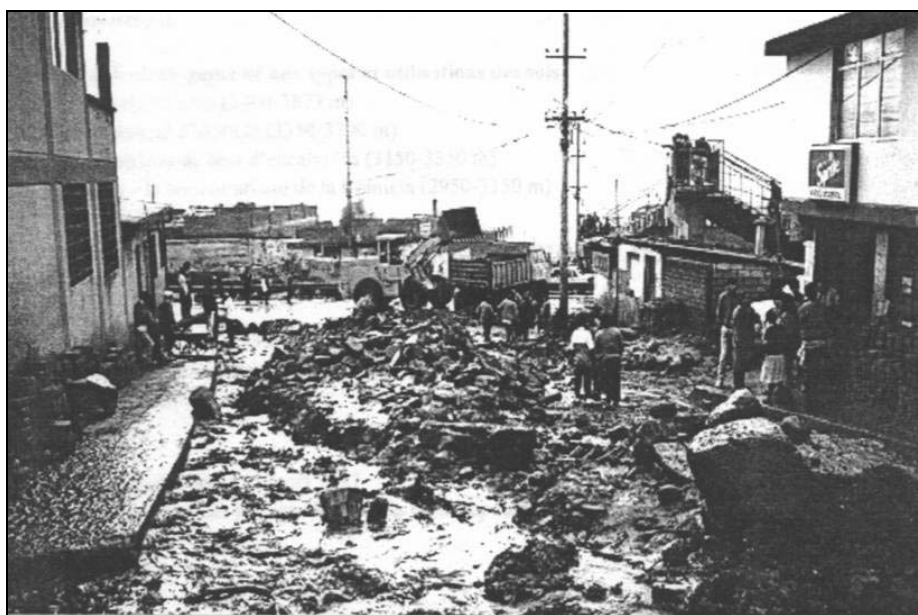
Photo 50 : Lave torrentielle du 31 mars 1997 (quartier La Comuna ) Dépôt de sédiments sur la chaussée – (Cliché : Perrin et al, 1997).
