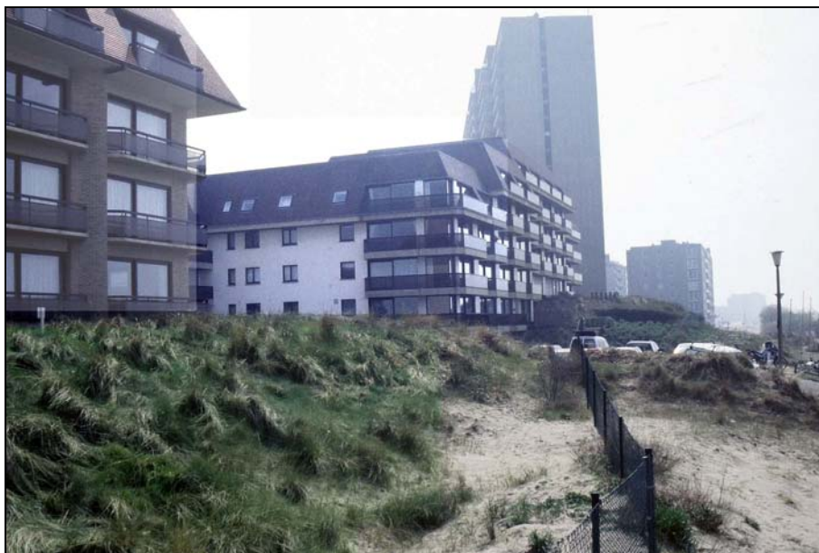
Photo 8. La digue de La Panne
