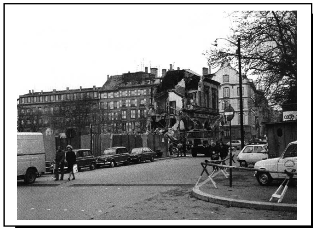
en 1974, sous un autre angle - au fond, l'ancienne gare en démolition
