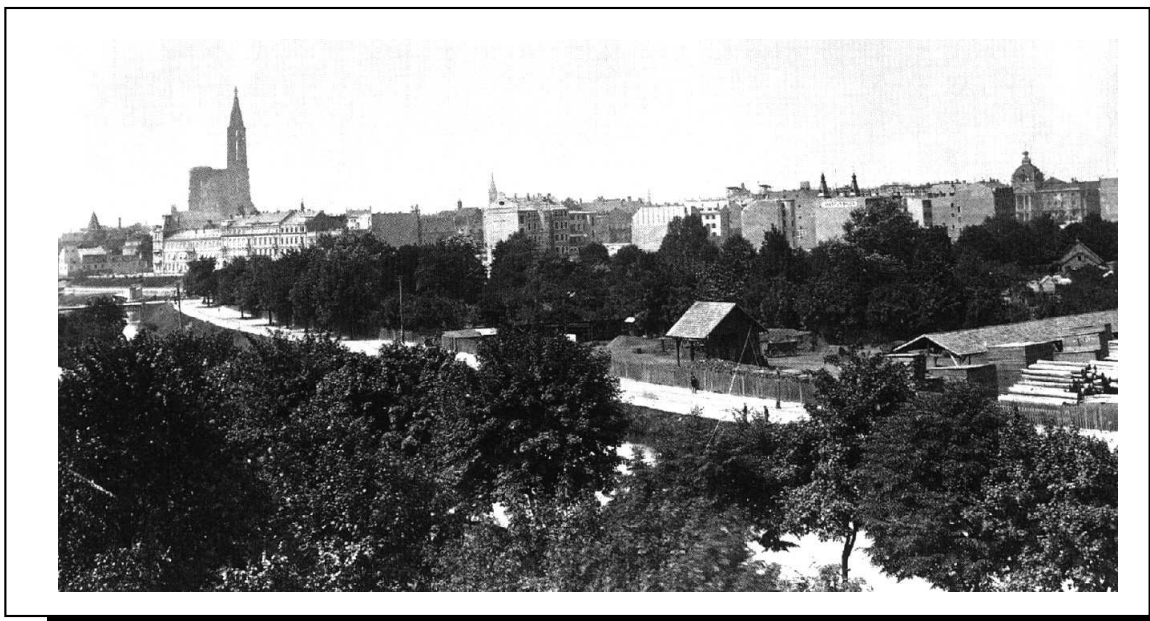
La Neustadt en 1910 n'en est qu'à ses débuts de construction
